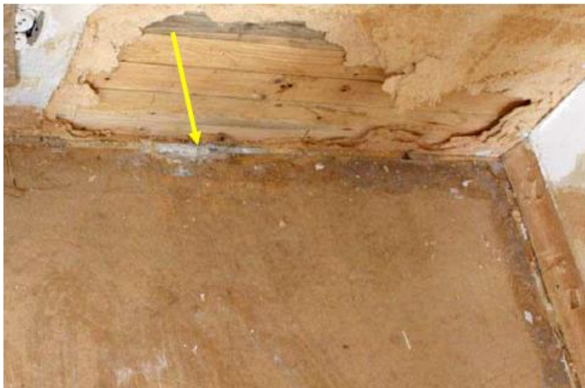
Bild 11. Det spacklade området i golvet på västra väggen innan golvet bryts upp. Inget synligt blod finns. Väggbeklädnaden av Tretex är delvis avlägsnad ner till golvnivå i samband med undersökningen. Gul pil markerar detta.
