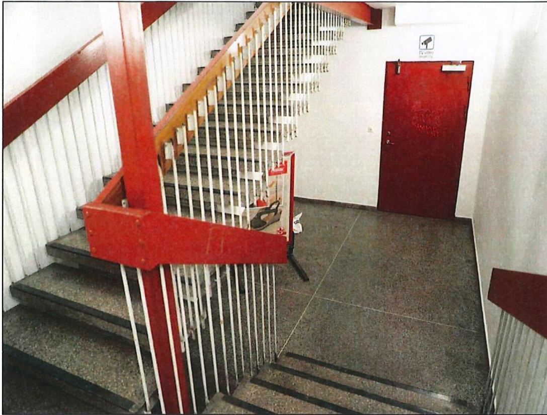
Foto i trapphuset mot dörren till slussen
