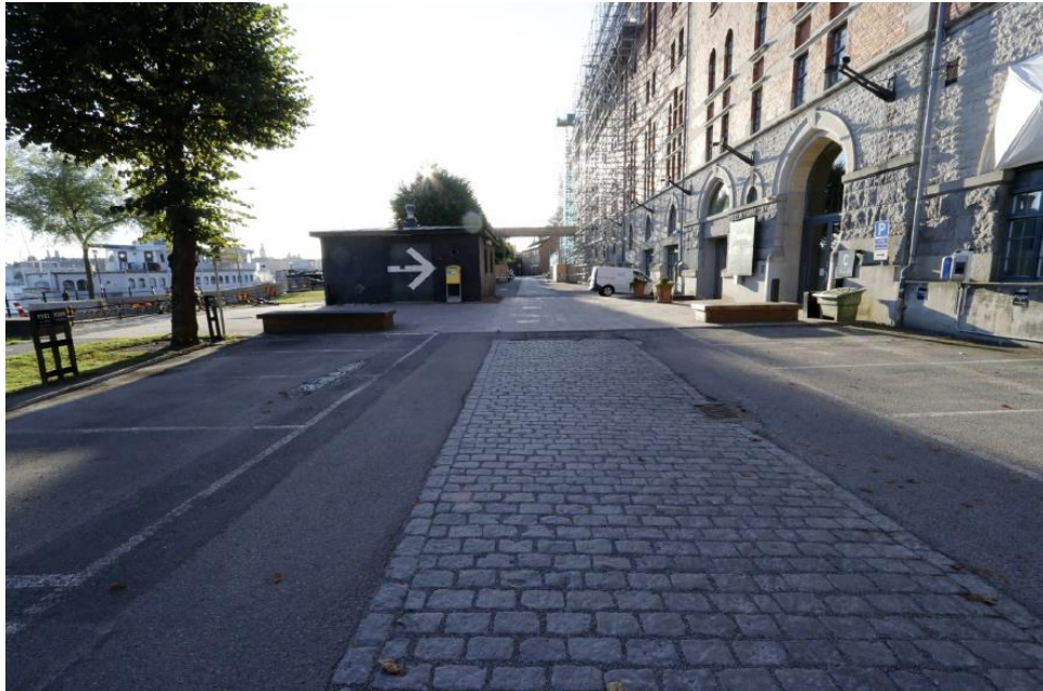
Förrådsbyggnadens högra kortsida.
