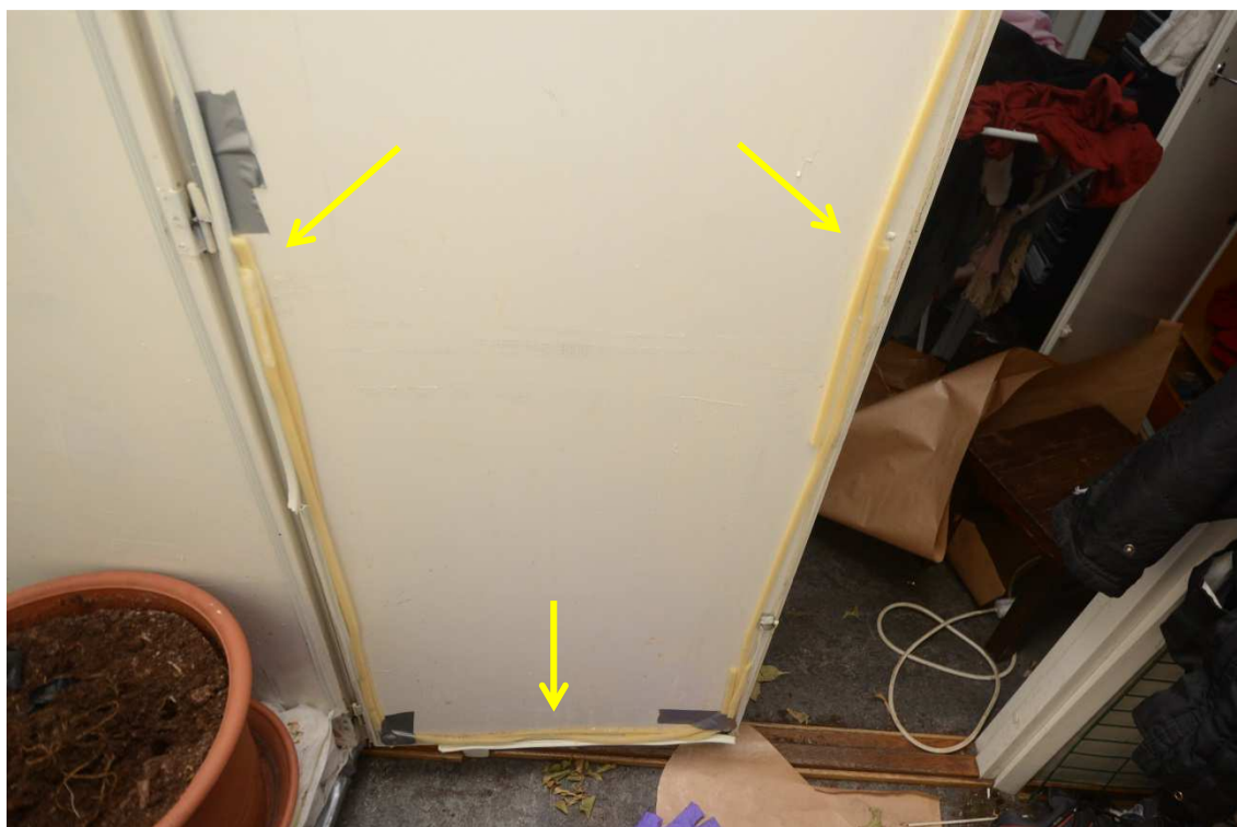
Figur 20. Pilar visar tätningslister runt garderobsdörrens insida.
