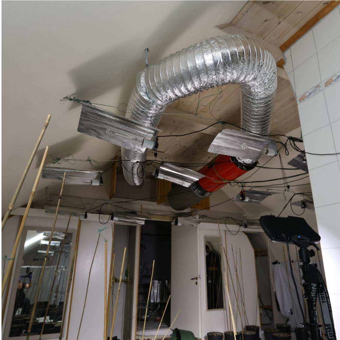
Figur 23. Ventilationsrör och odlingslampor med reflektorer i taket.
