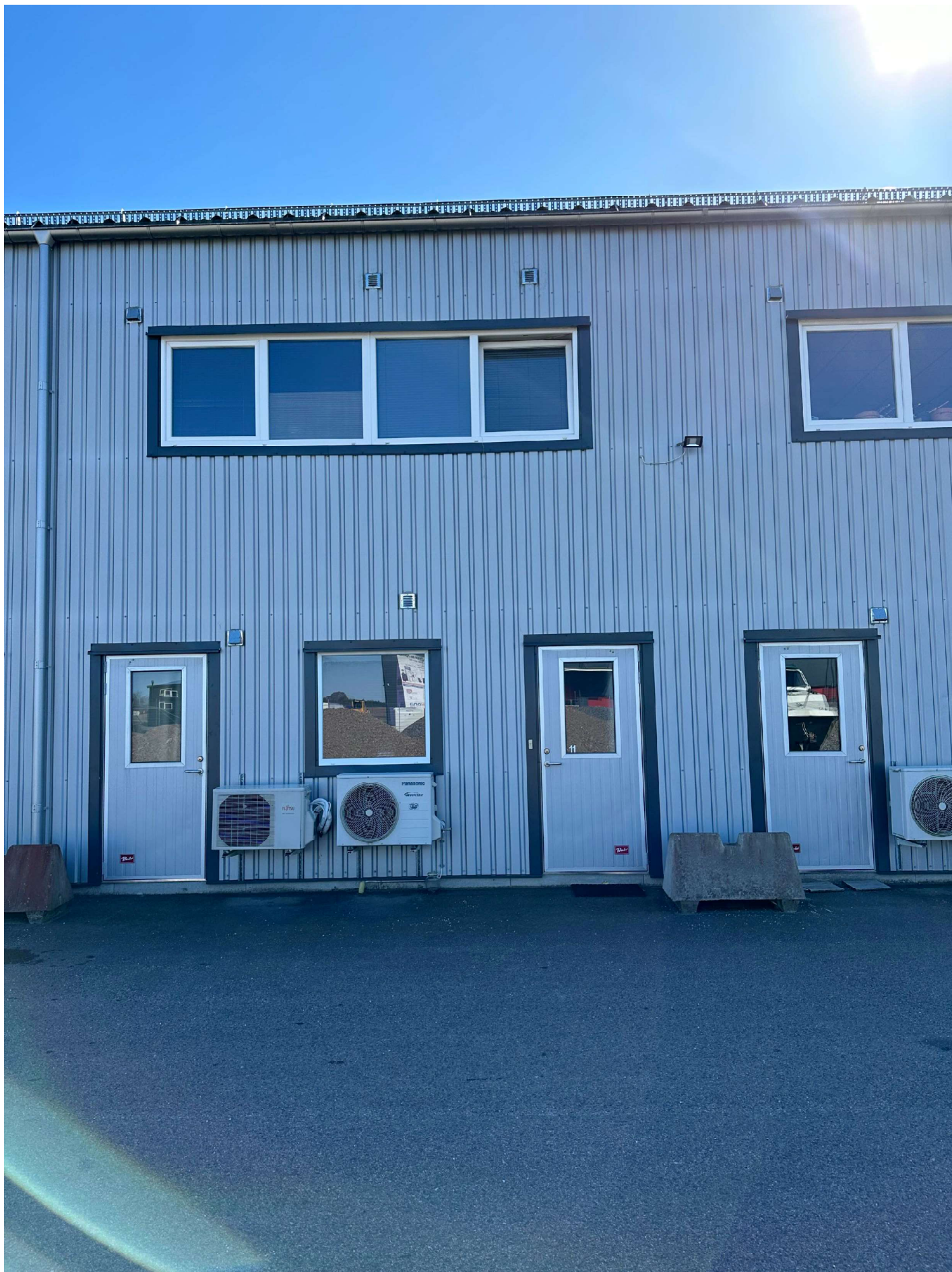
23. Foto taget från baksidan av fastigheten till garage nr 11
