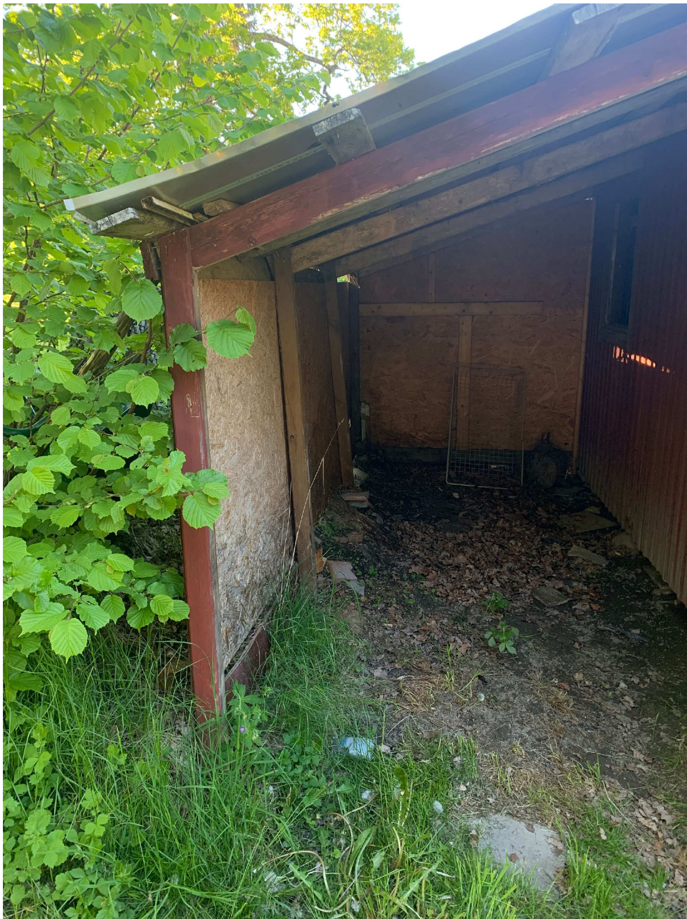
4. Skjul på Skarpängsvägen 11B
