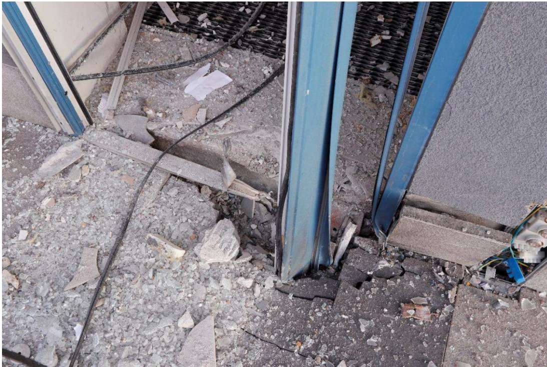
Figur 11. Krevadgropen sedd från utsidan.
