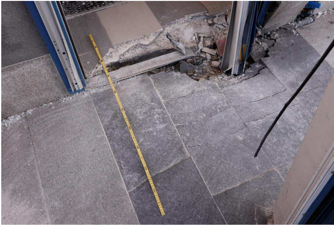
Figur 13. Krevadgropen efter friläggning. Koncentrisk sprickor ses kring krevadgropen. Bilden är tagen norrut.
