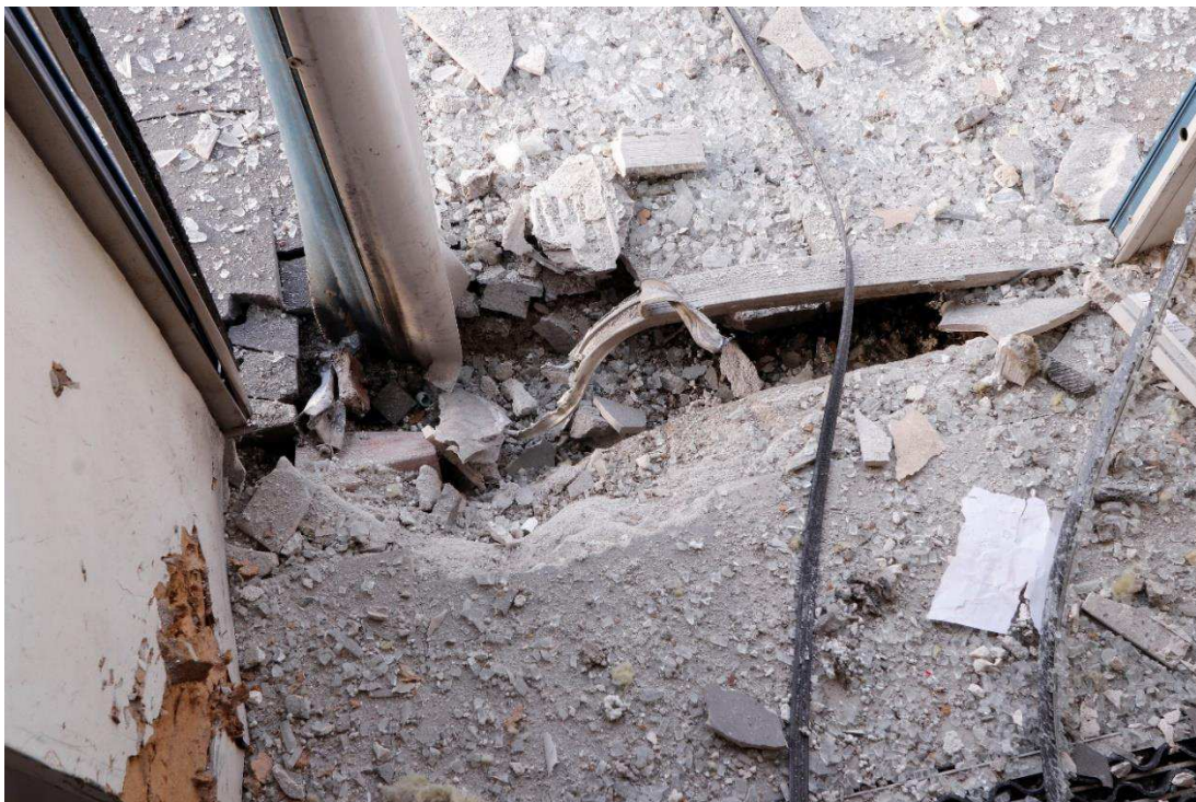
Figur 12. Krevadgropen sedd från trapphuset. Bilden är tagen söderut.
