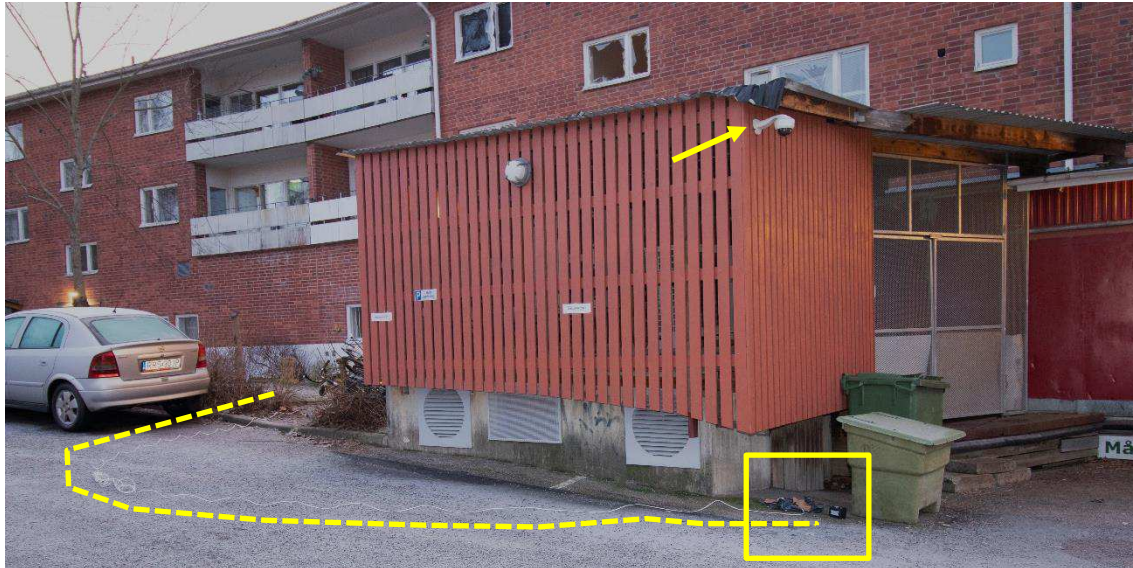
Figur 14. Kortsidan och den andra långsidan av utbygganden. Den streckade linjen avser att visualisera dragningen av den vita elkabeln fram till ett 12 V batteri. Pilen markerar en övervakningskamera.
