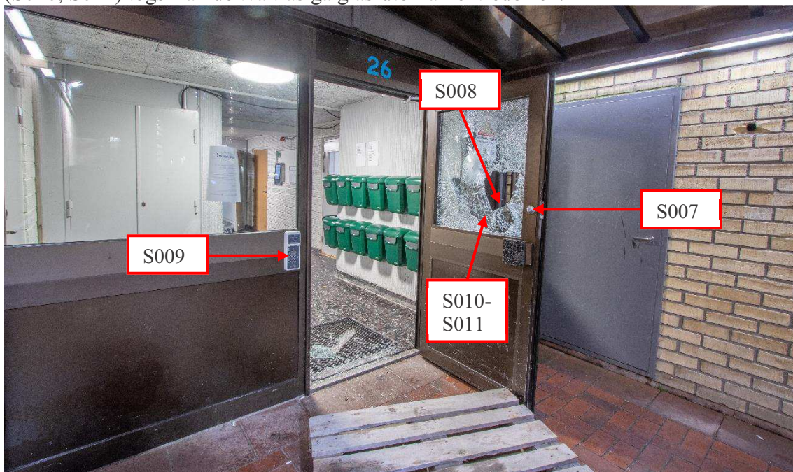
Figur 5. Södra entrén. S007-S011 markerade i bild.
