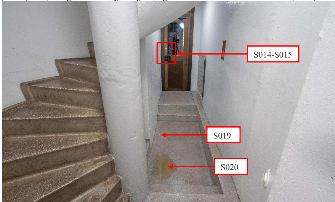
Figur 8. Trapphus entréplan. Vit portionssnusprilla (S019), vätska bedömt som urin (S020) samt låsvred (S014) och tryckhandtag (S015) som topsades är markerade i bild.
