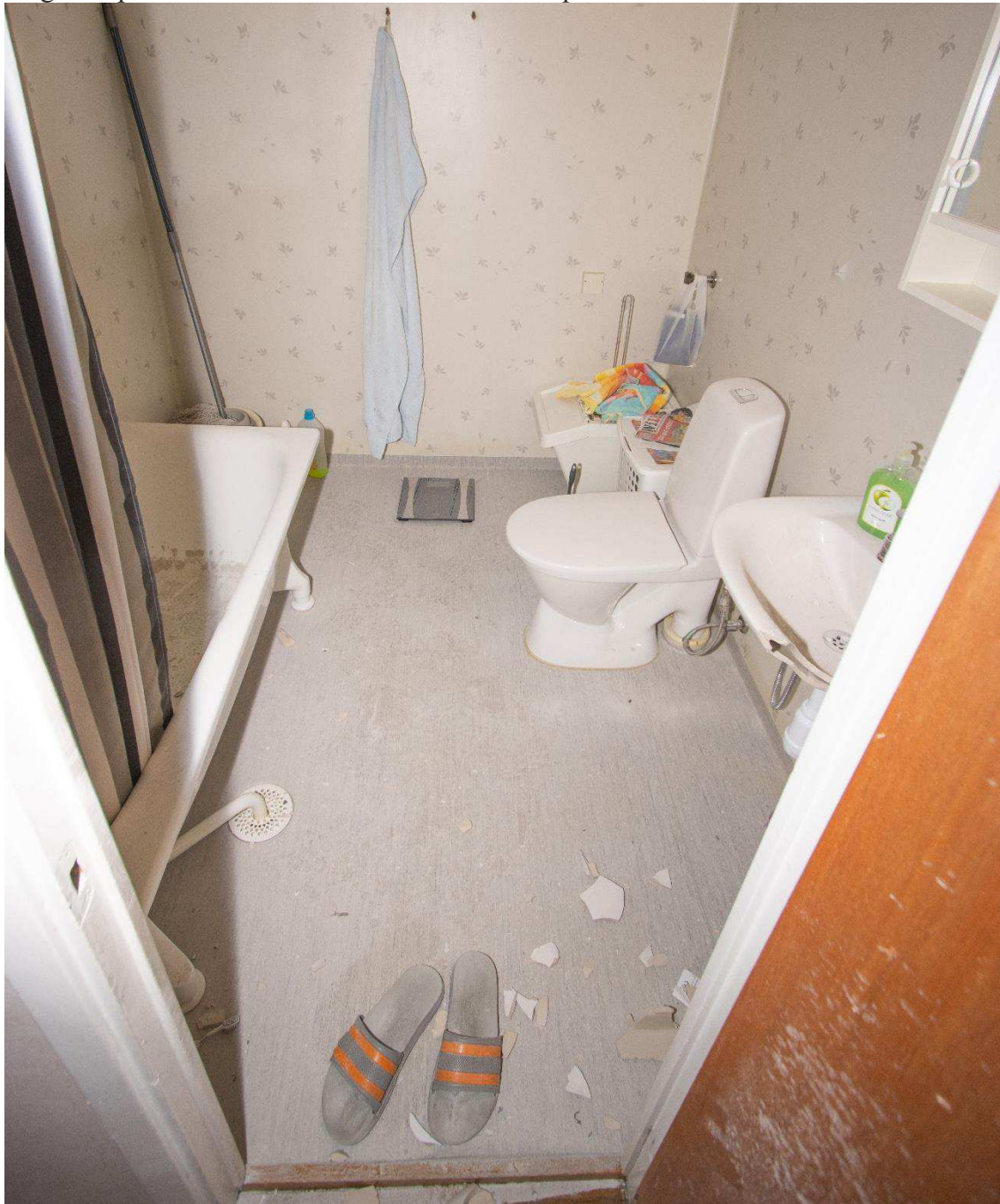
Figur 12. Badrummet sett från badrumsdörren.
