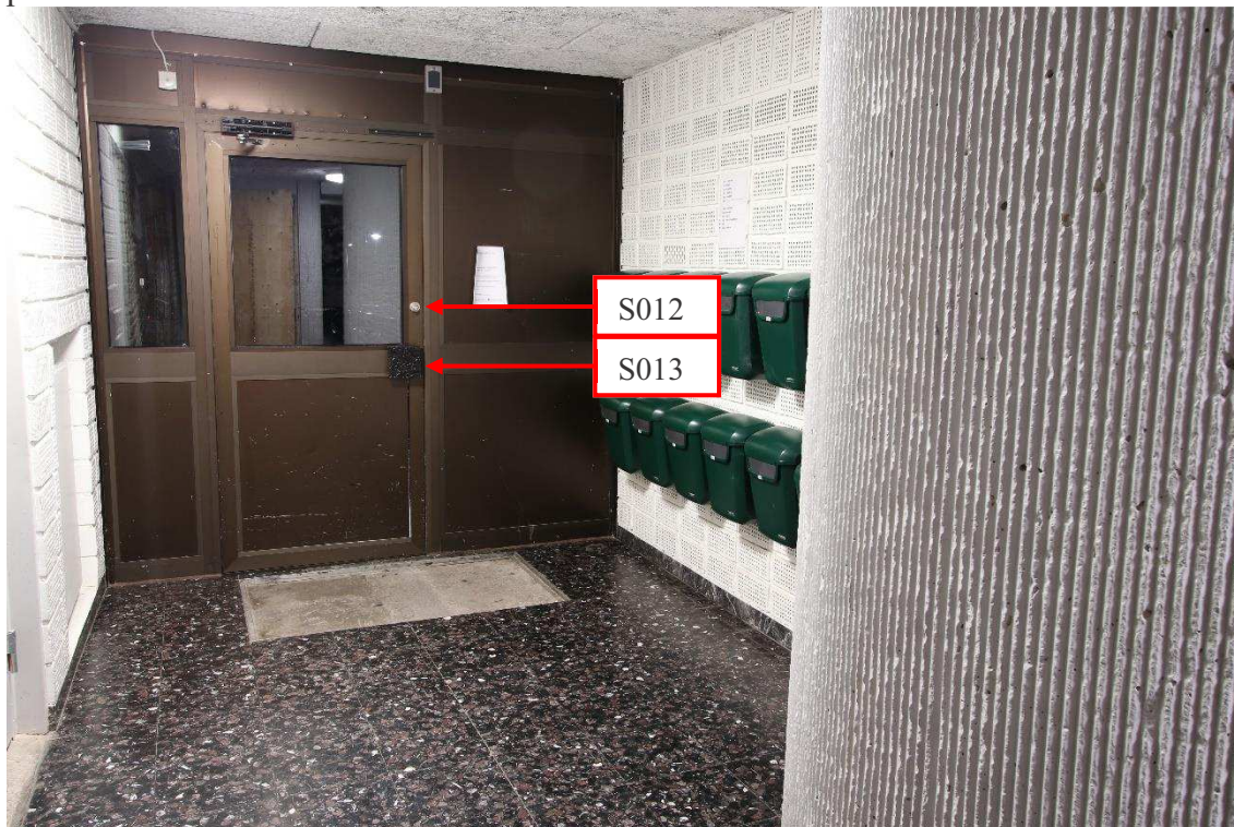
Figur 6. Stora porten vid norra entrén. Låsvred (S012) och tryckhandtag (S013) som topsades är markerade i bild.
