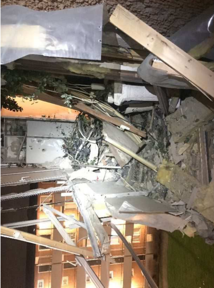
Tönsbergsgatan, Husby, Stockholm jan 2020. Beräknad explosivälmnesmängd ca 3 kg. Detonerade på lofftång med strukturella skador på byggnadskonstruktionen.
