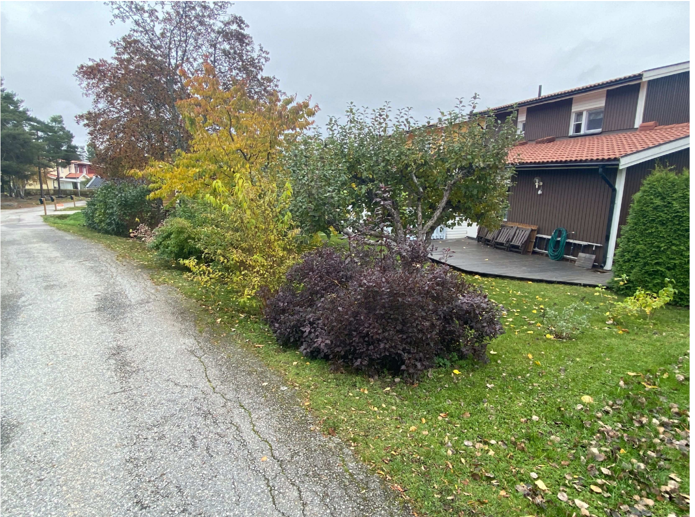
15. Bild 6. Baksida av Zetterlunds väg 7a. Nästa bild är fotograferad motsols i en cirkel för att få en överblick av omgivningen.. Bild tagen av Pa. Holst-Larsen.
