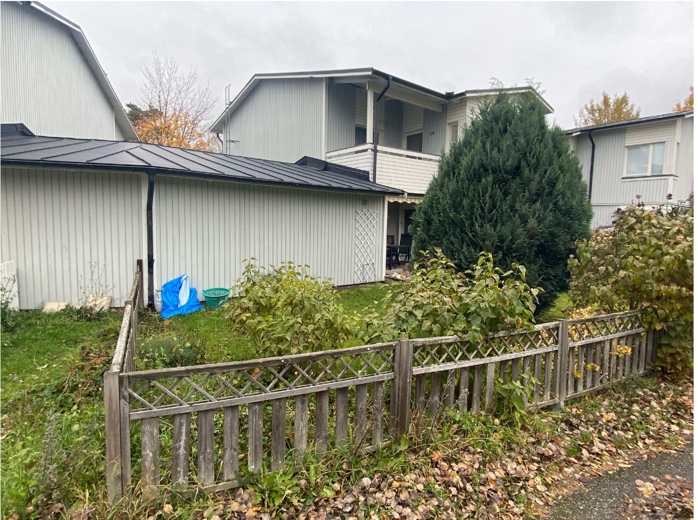
11. Bild 1. Baksida av Zetterlunds väg 7a. Nästa bild är fotograferad motsols i en cirkel för att få en överblick av omgivningen.. Bild tagen av Pa. Holst-Larsen.
