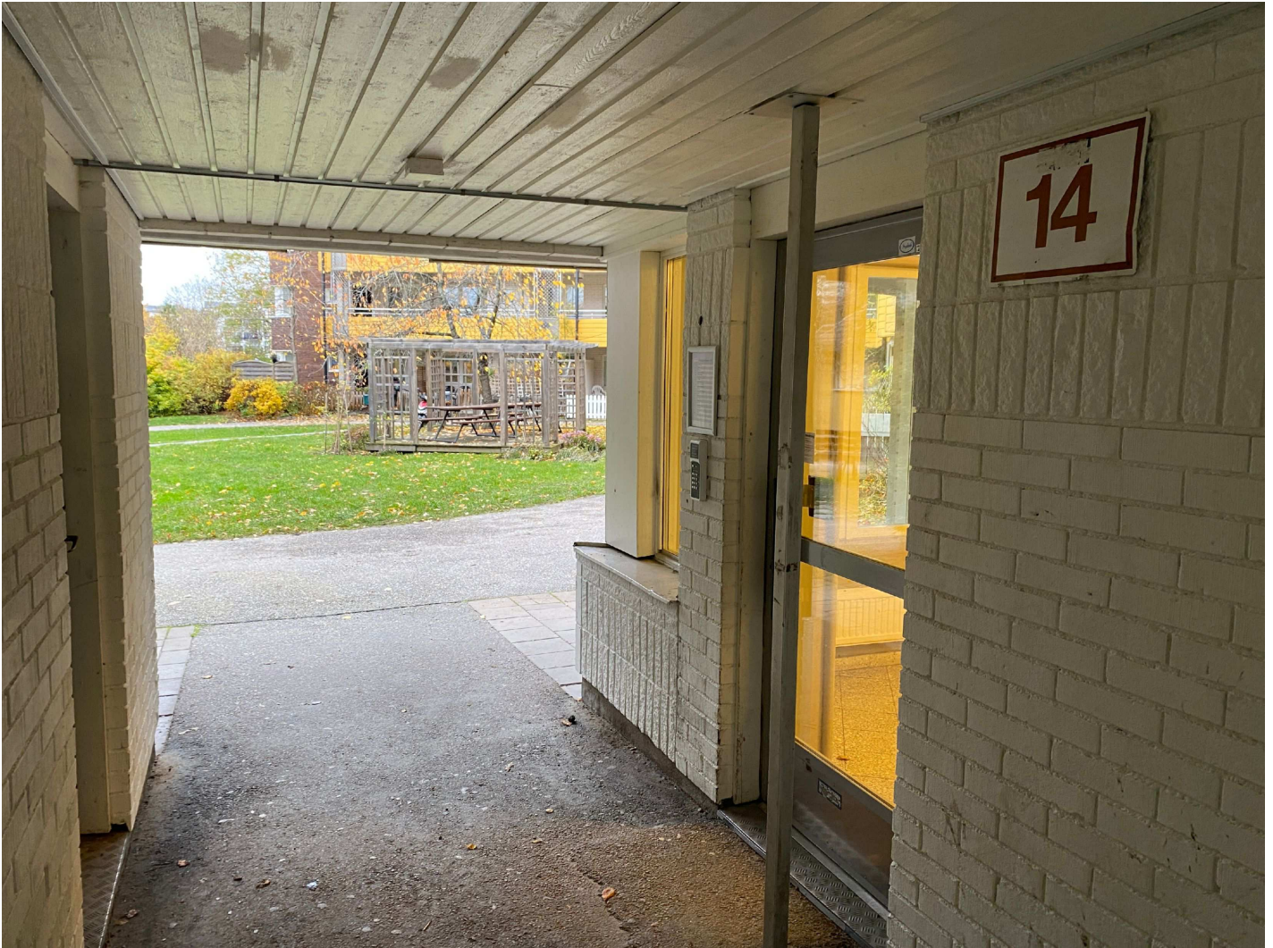
22. Portal vid port 14 in mot innergård.
