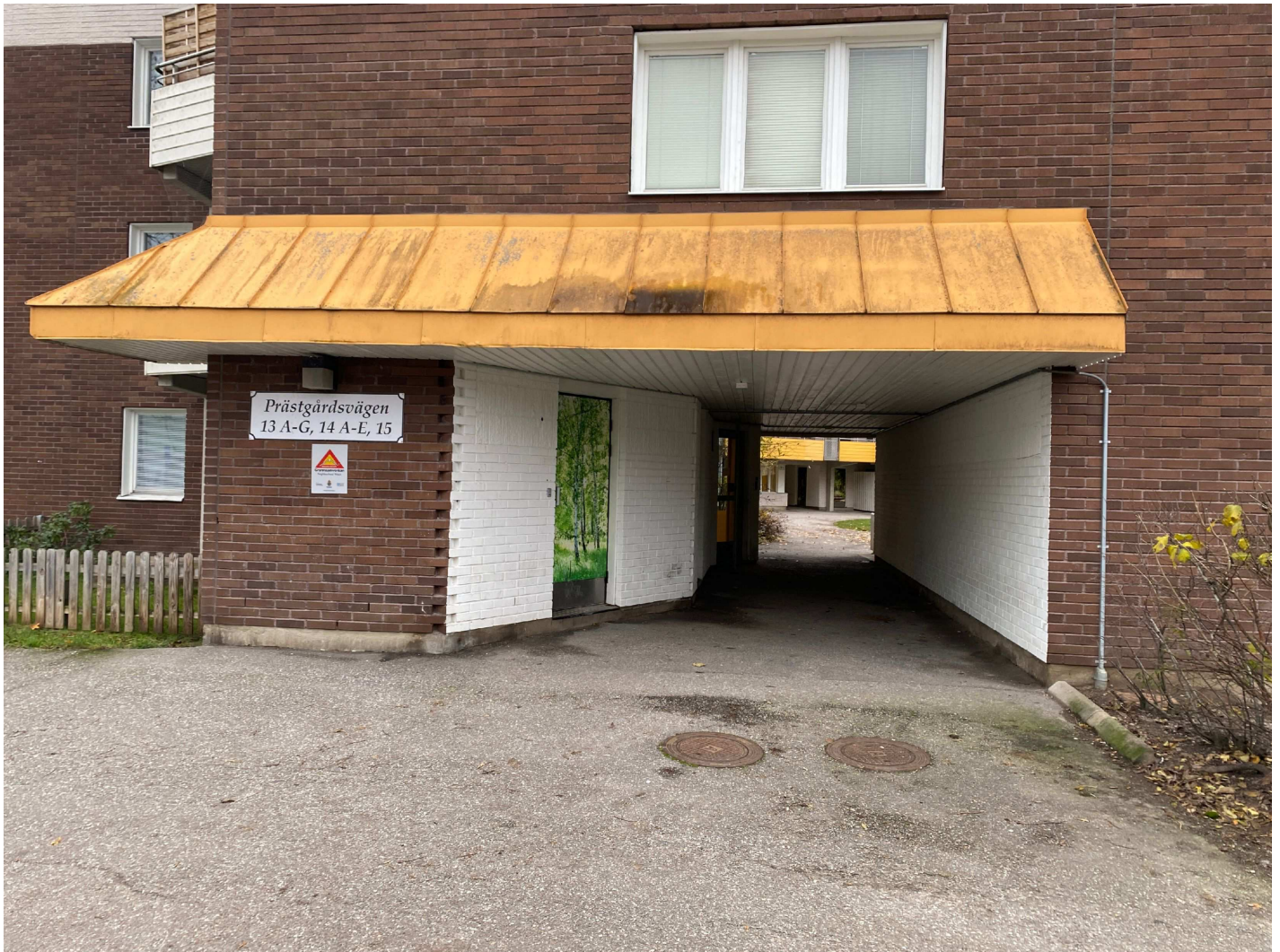
5. Portal in mot innergård, port nr. 13 i portalen.
