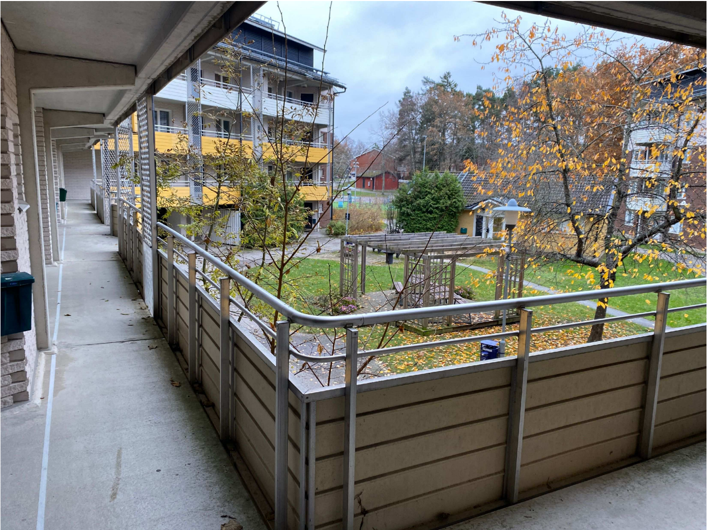
11. Våning 1 loftgång, avspärrad lägenhet till höger
