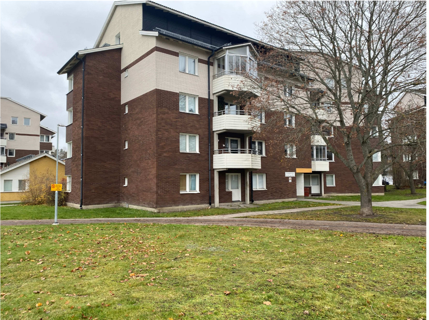
32. Huskropp vid portal nr 14.
