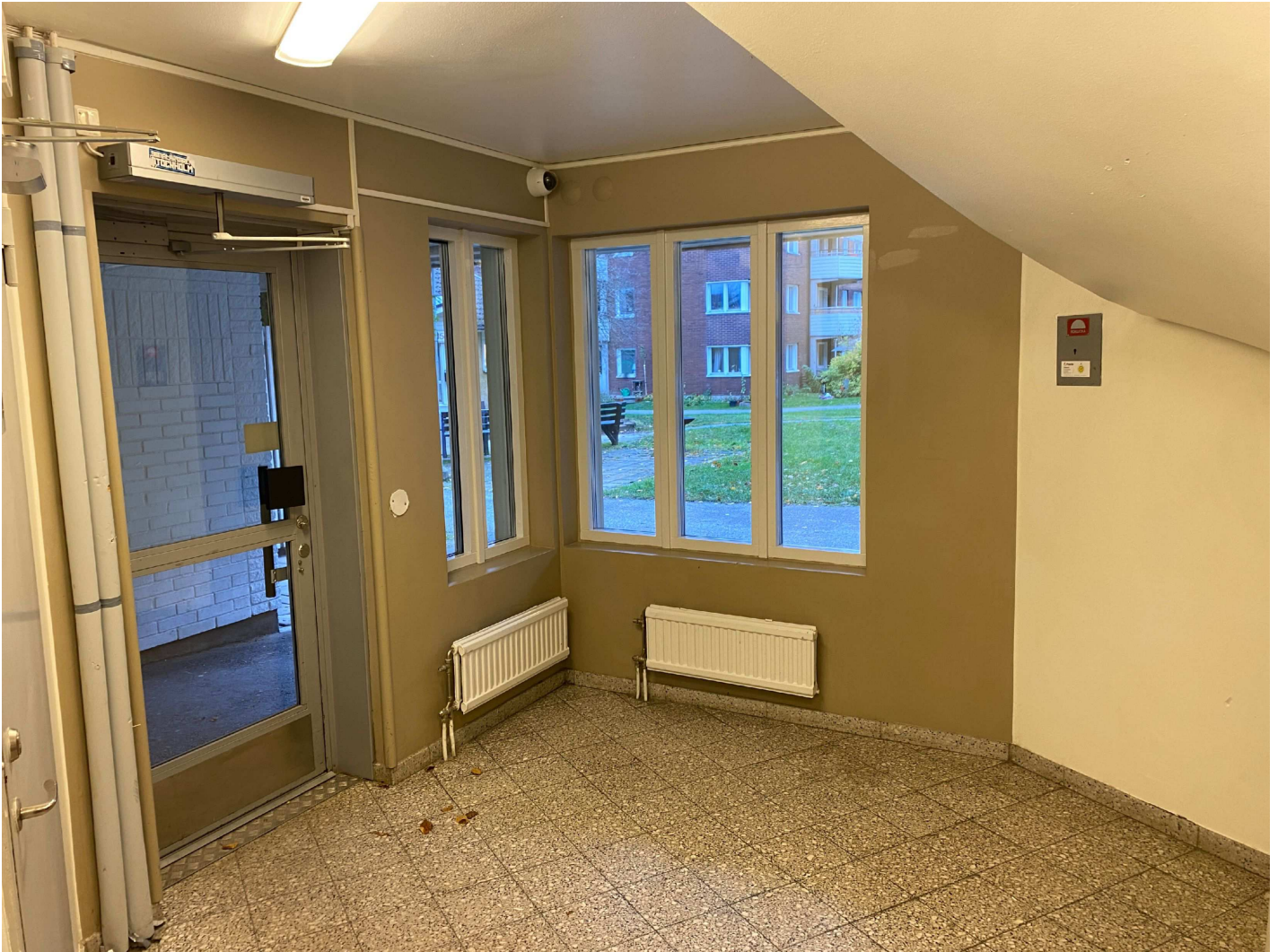
20. Trapphus bottenplan nr. 14, kamera monterad i övre del av bilden och filmar mot trapp/hiss.
