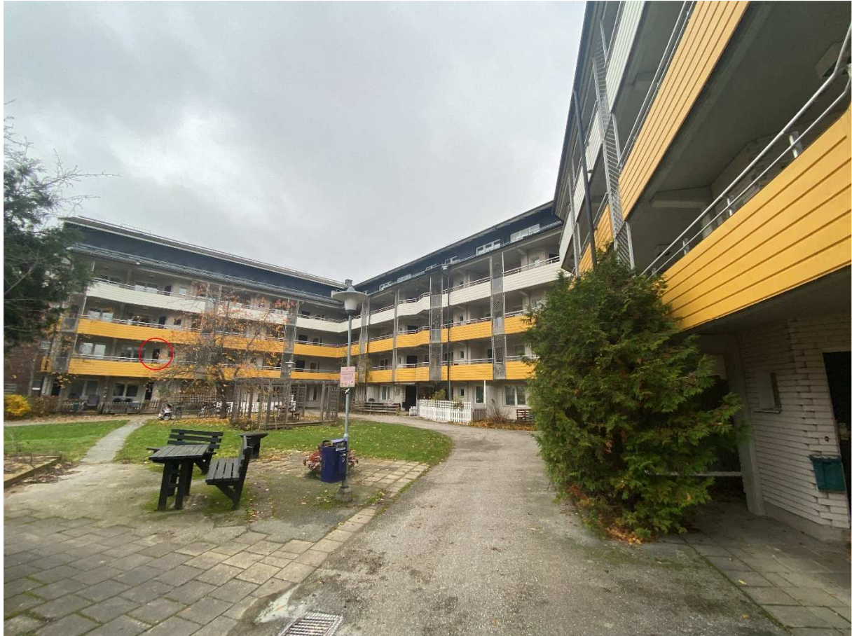
Bild tagen på Prästgårdsvägen 13 och 14 från innergården sett. Nummer 13 är den vänstra delen av huskroppen, nummer 14 den högra delen av huskroppen. Tewars lägenhet inringad.
