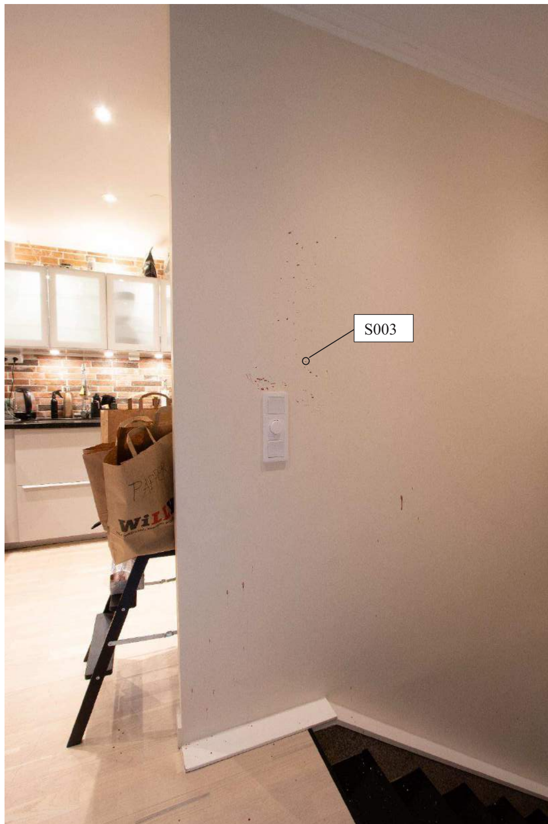
Figur 11. Avkastat blod på den vänstra väggen längst upp i trapphuset.
