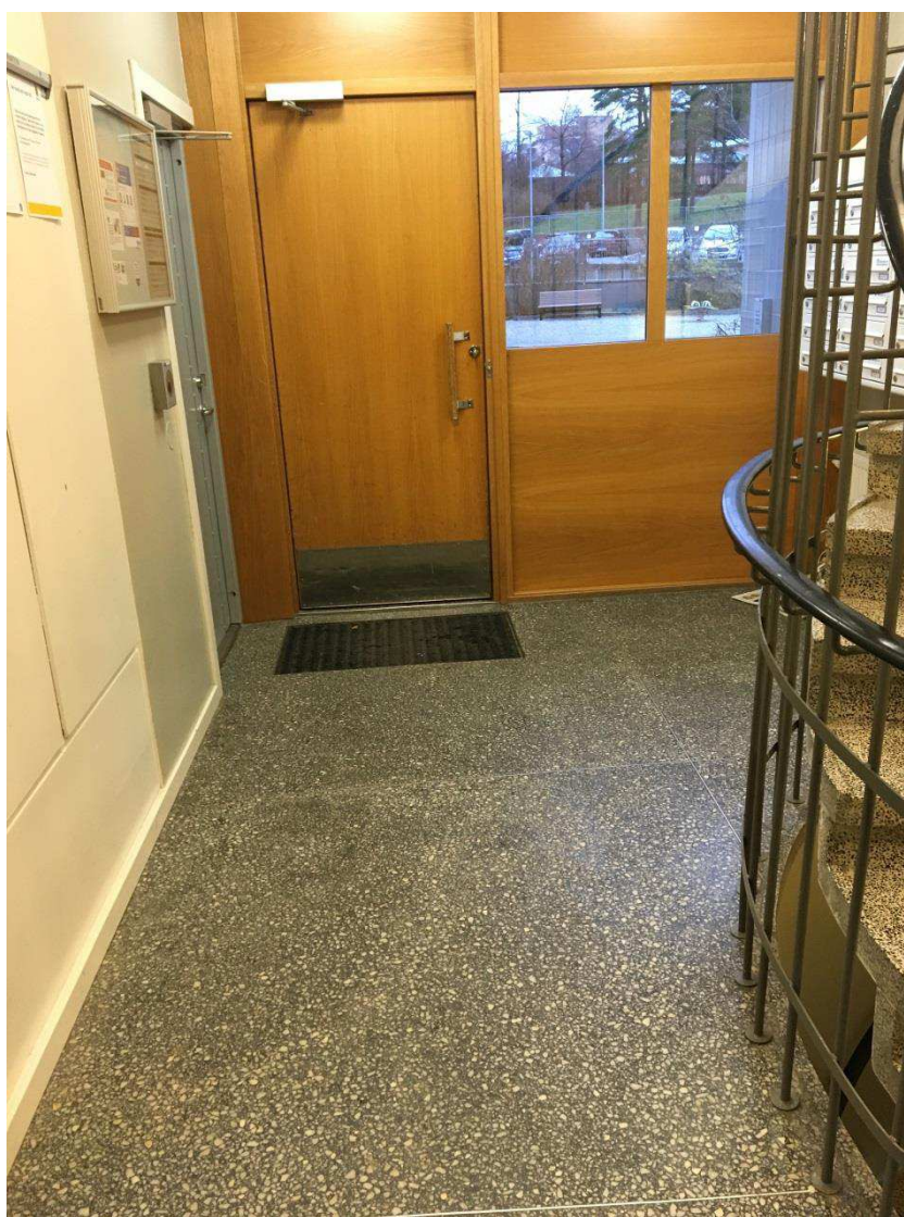
Bild 7. Porten till Ribbings väg 64 A, sett inifrån fastigheten.
