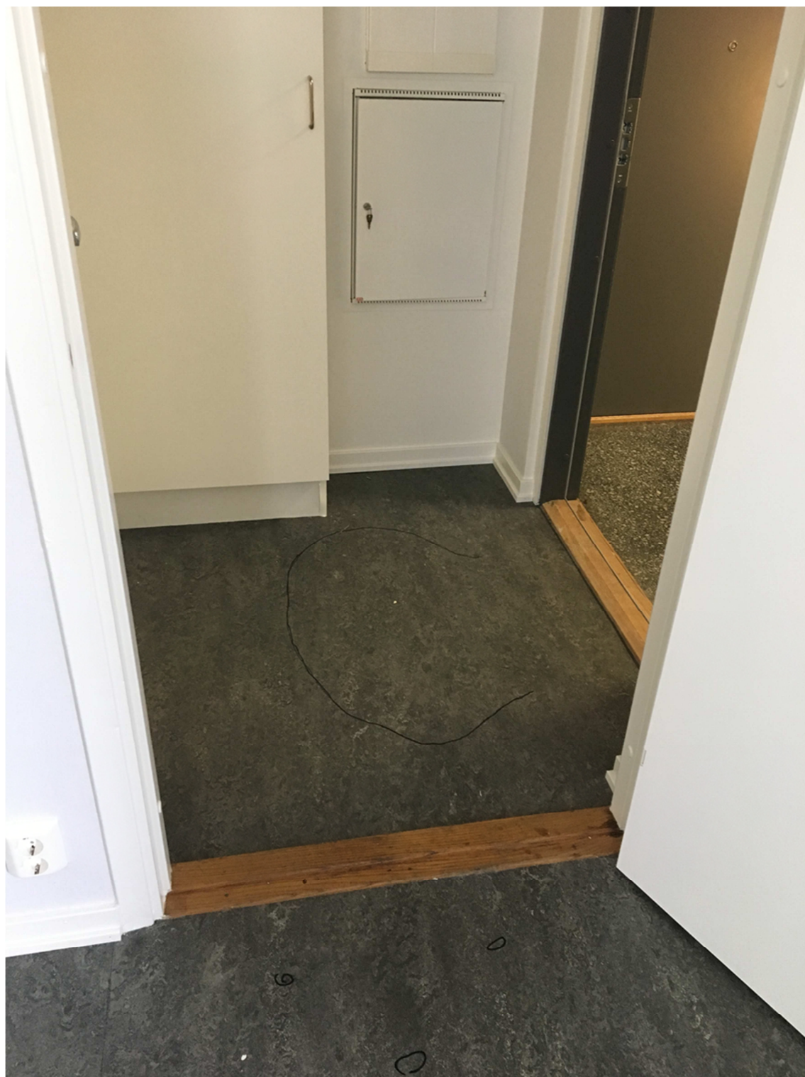
Bild 4. Närbild på hallgolvet och vardagsrumsgolvet.
