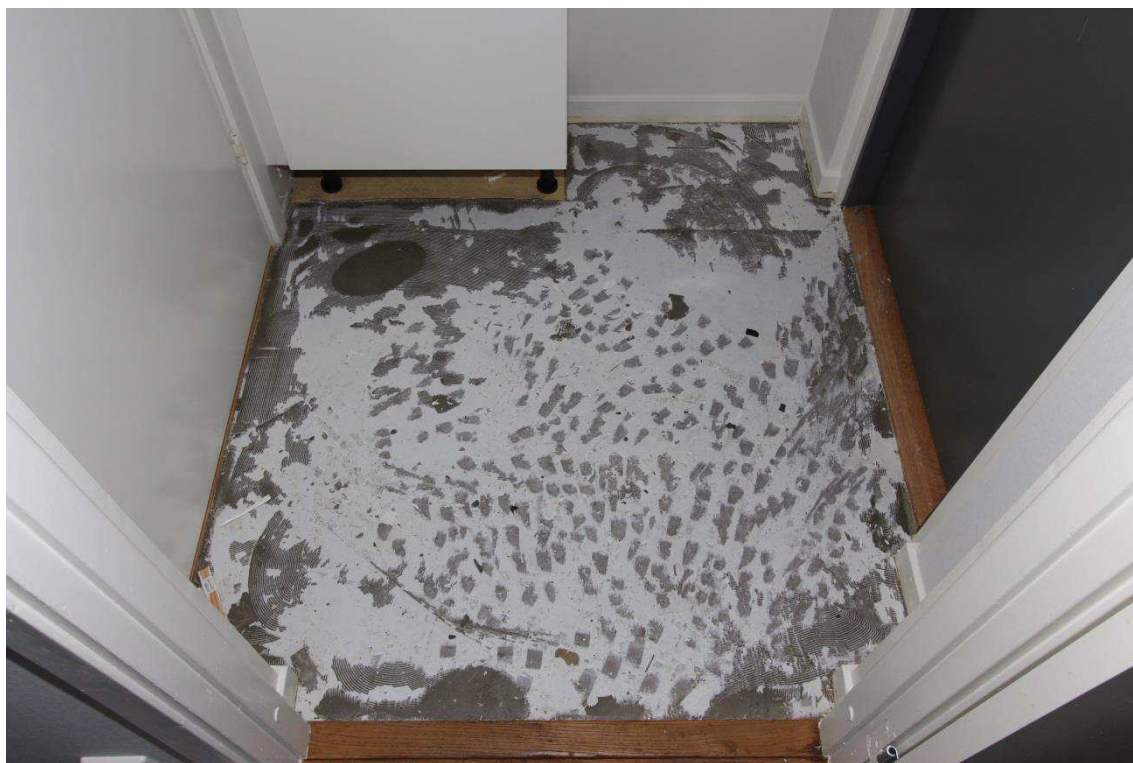
11. Hallen efter att linoleumgolvet rivits upp.
