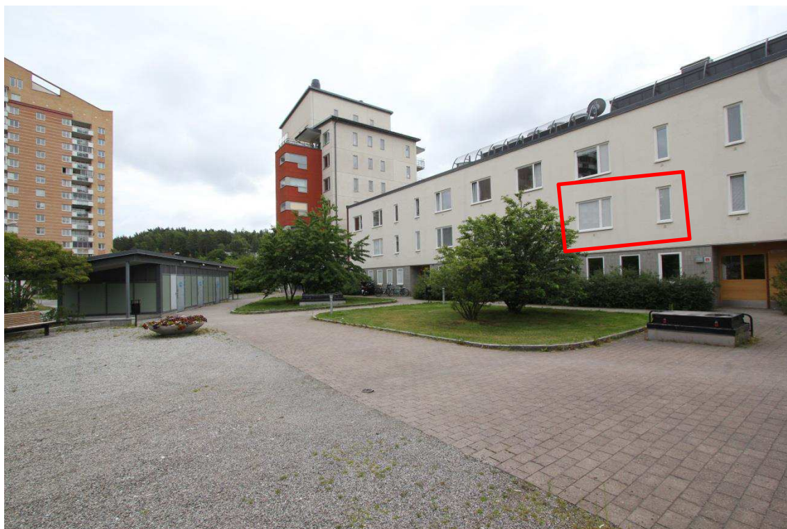
3. Fastigheten, sett från innergården ut mot Ribbings väg. Aktuell lägenhet markerad i bilden. Infart till innergården är under det utskjutande taket vid det gröna förrådet till vänster i bild.
