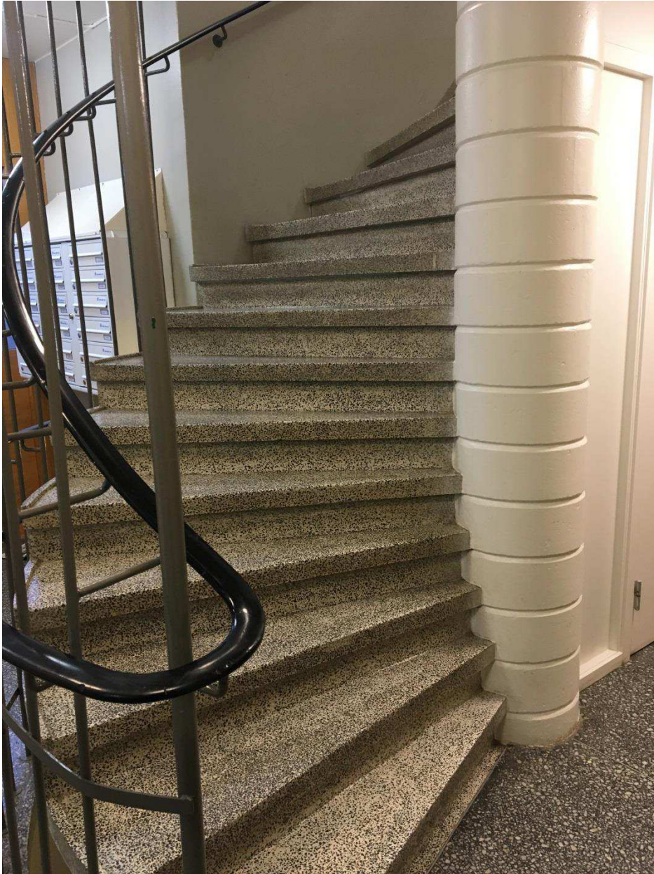
Bild 8. Trappa i fastigheten på Ribbings väg 64 A. Från entréplan sett uppåt.
