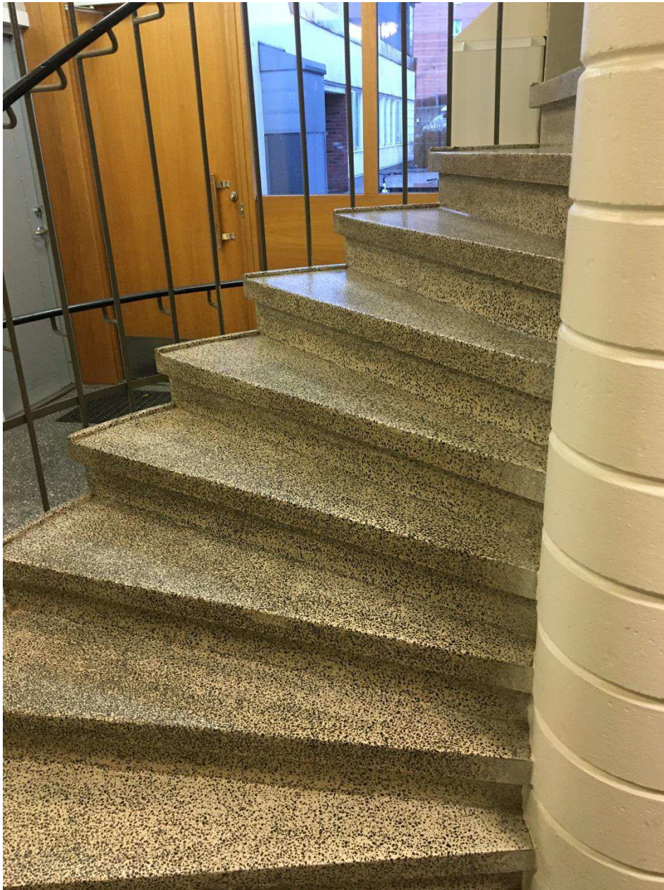
Bild 9. Trappa i fastigheten på Ribbings väg 64 A. Från entréplan sett uppåt.
