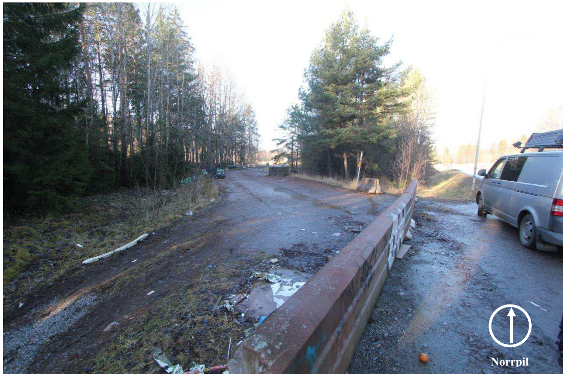
Figur 3 Infart från Stockholmsvägen den avstängda räddningspåfarten mellan E4 och Stockholmsvägen.
