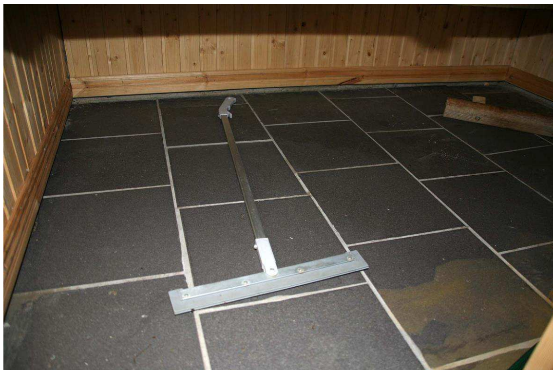
Figur 9 Klinkergolv i Förråd/bastu
