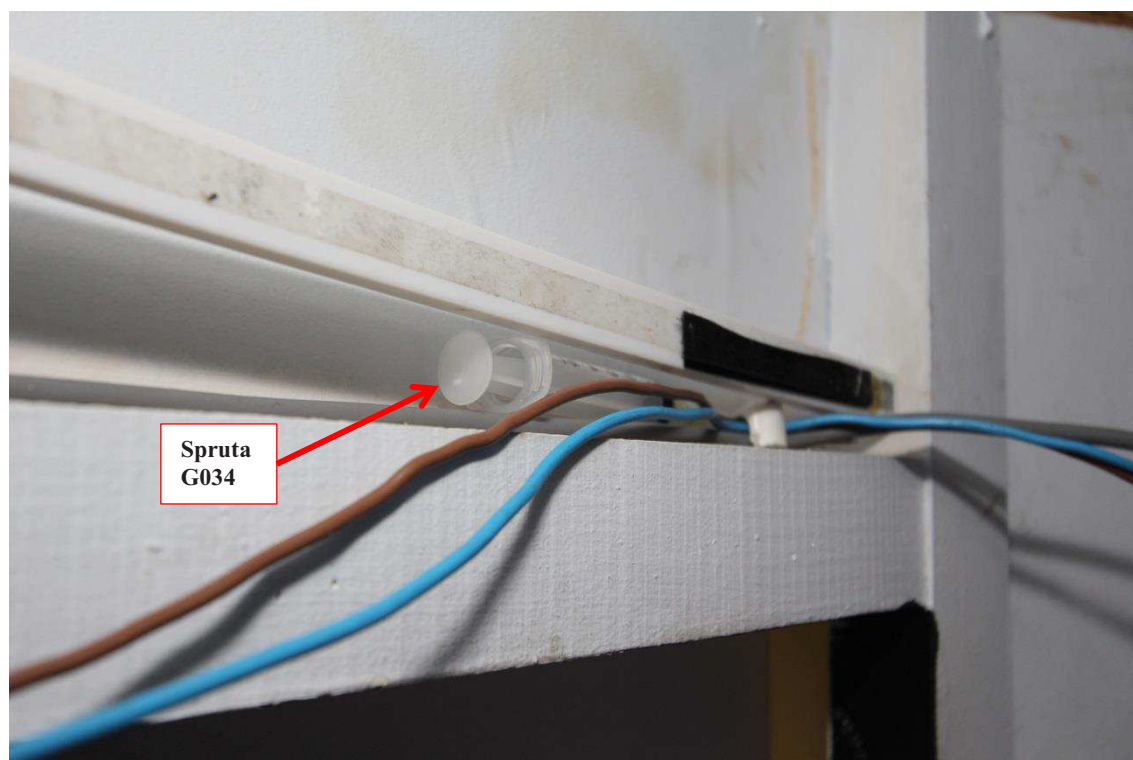
Bild 33. Spruta med kanyl, (G034) ovanför toalettdörren i wc-utrymmet.
