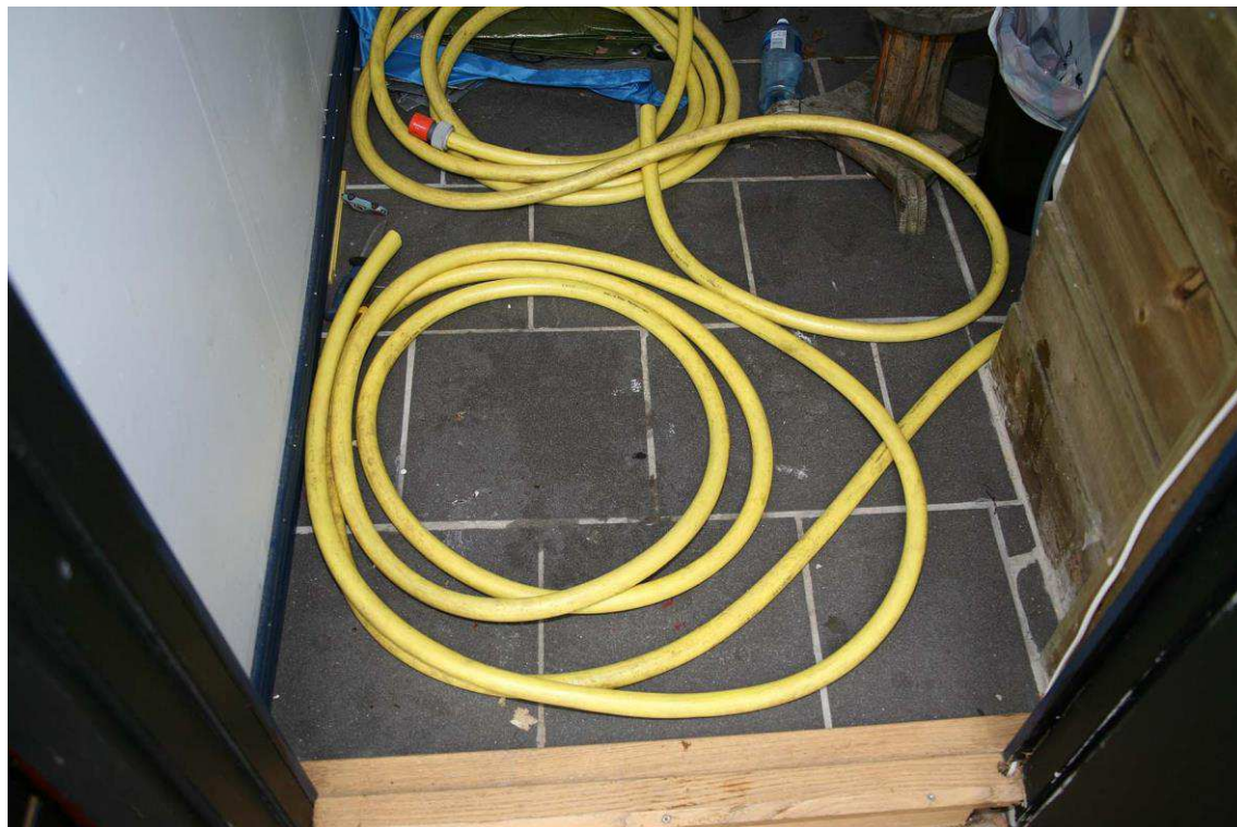
Figur 8 Klinkergolv i förråd/bastu belägen i trädgården.
