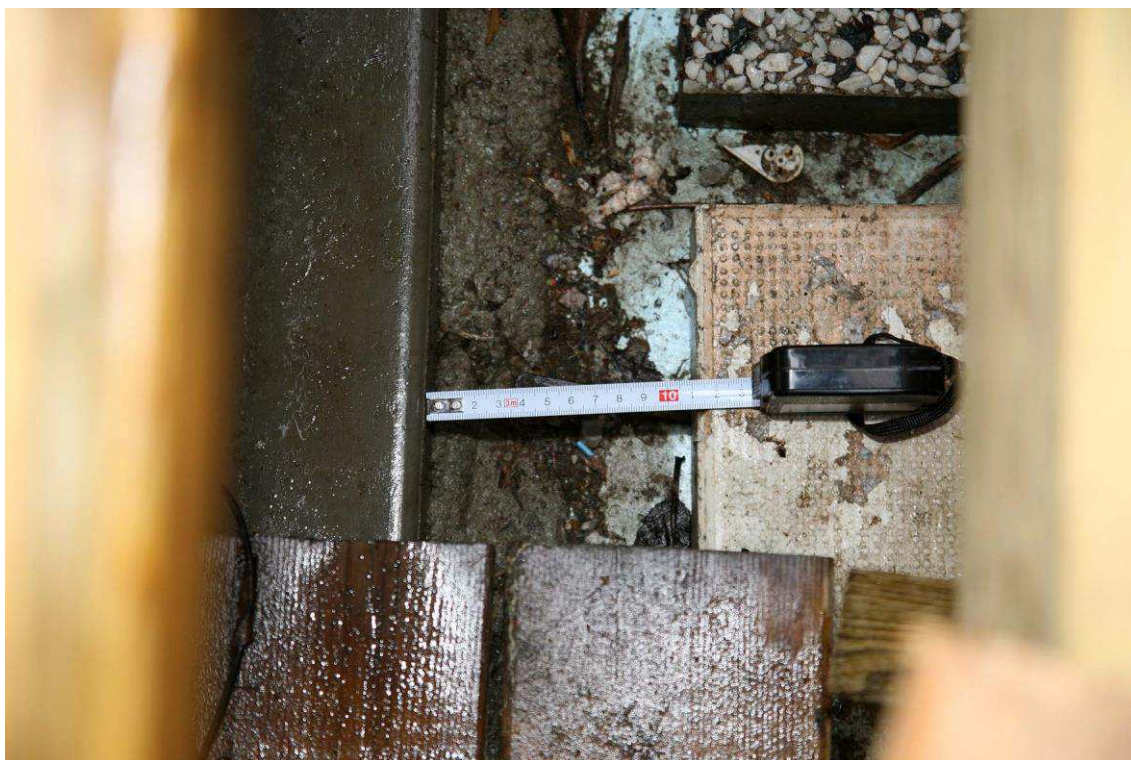
Figur 4 Kantsten fastgjuten med betong
