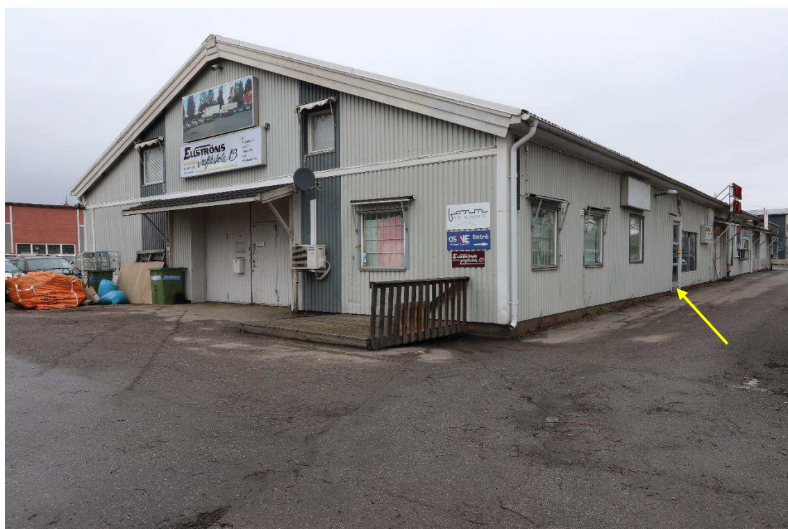
Figur 4. Byggnadens kortsida samt den södra långsidan, entrédörren till aktuell lokal markerad med en pil.
