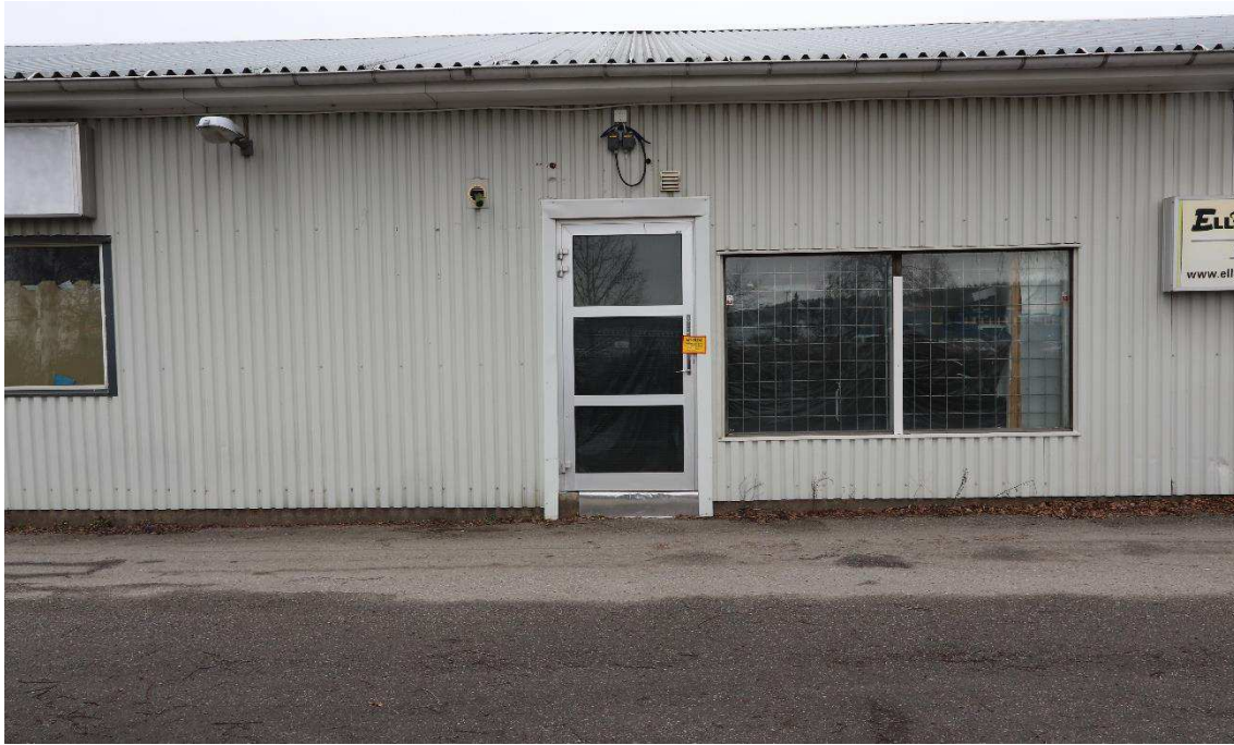
Figur 5. Entrédörren till aktuell lokal.
