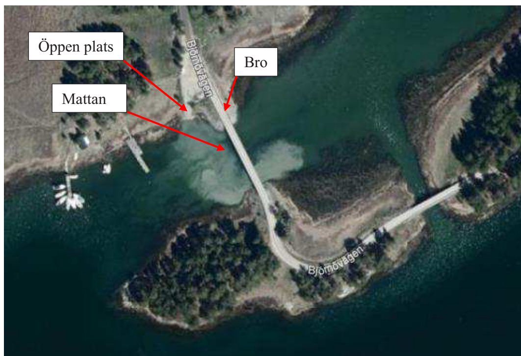
Figur 1. Satellitbild från hitta.se 2023-06-09. De röda pilarna markerar den öppna platsen, bron och där mattan anträffades i vattnet.
