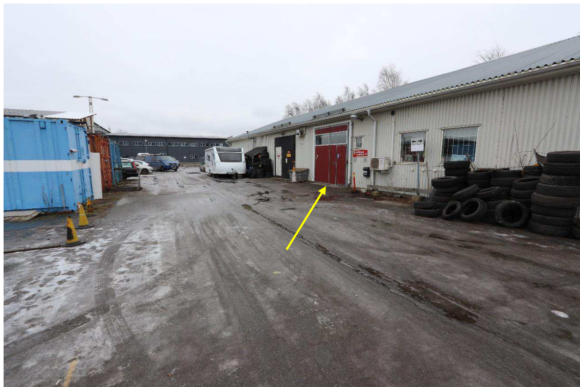
Figur 2. Byggnadens norra långsida, garageporten markerad med en pil.
