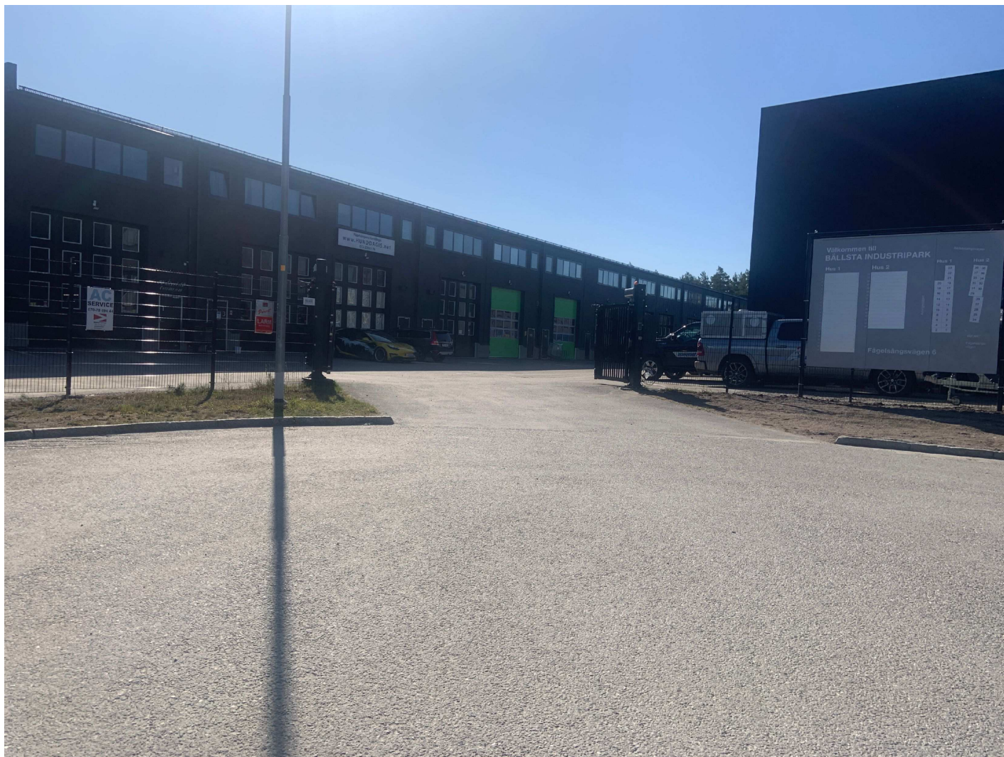
1. Bild tagen Fågelsångsvägen 6 vändzonen in mot företagshotellet. Bild visar grind in mot området.
