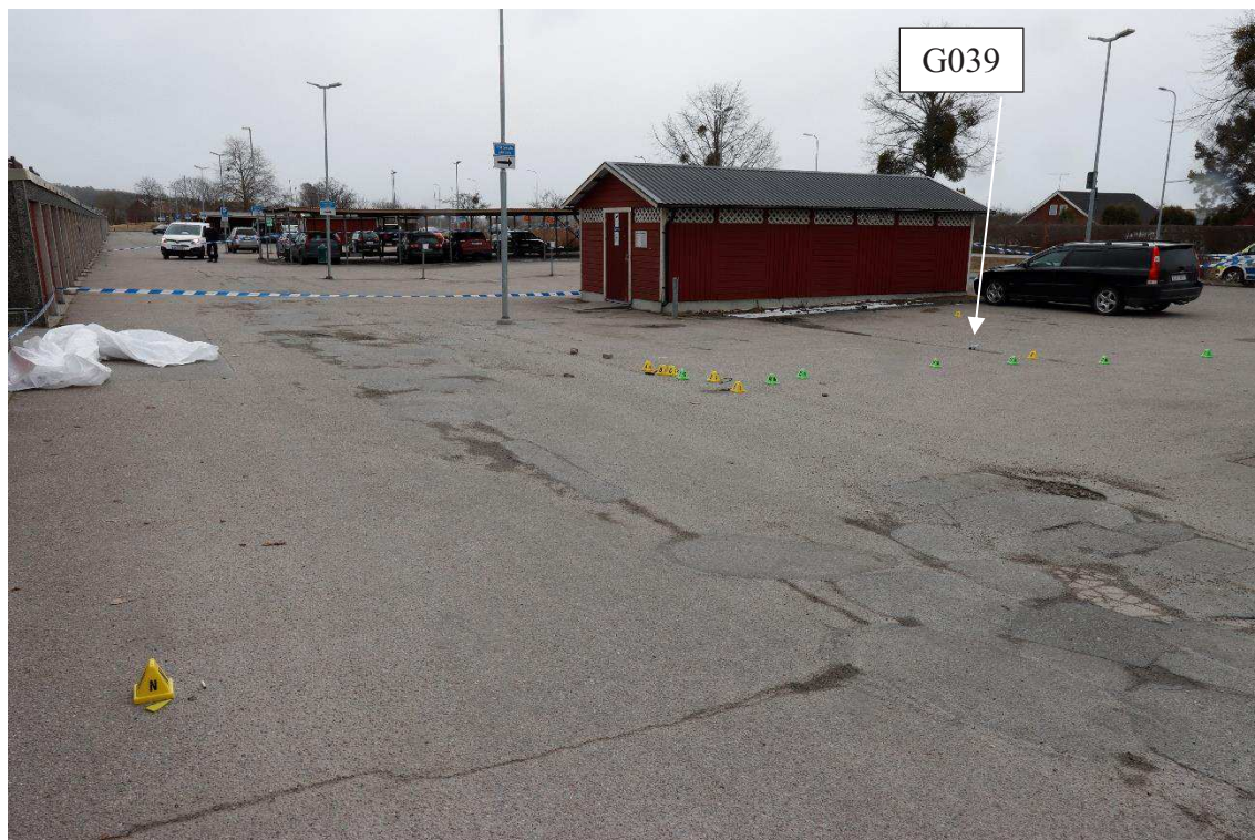
Figur 14: Parkeringen vid Fjärilsstigen 14.
