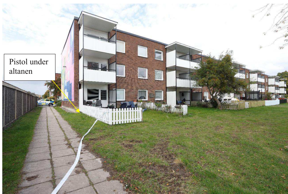
Figur 4: Baksidan av fastigheten.
