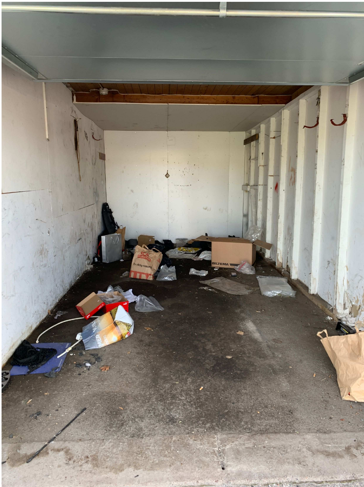
3. Garage 27 på Fasanstigen.
