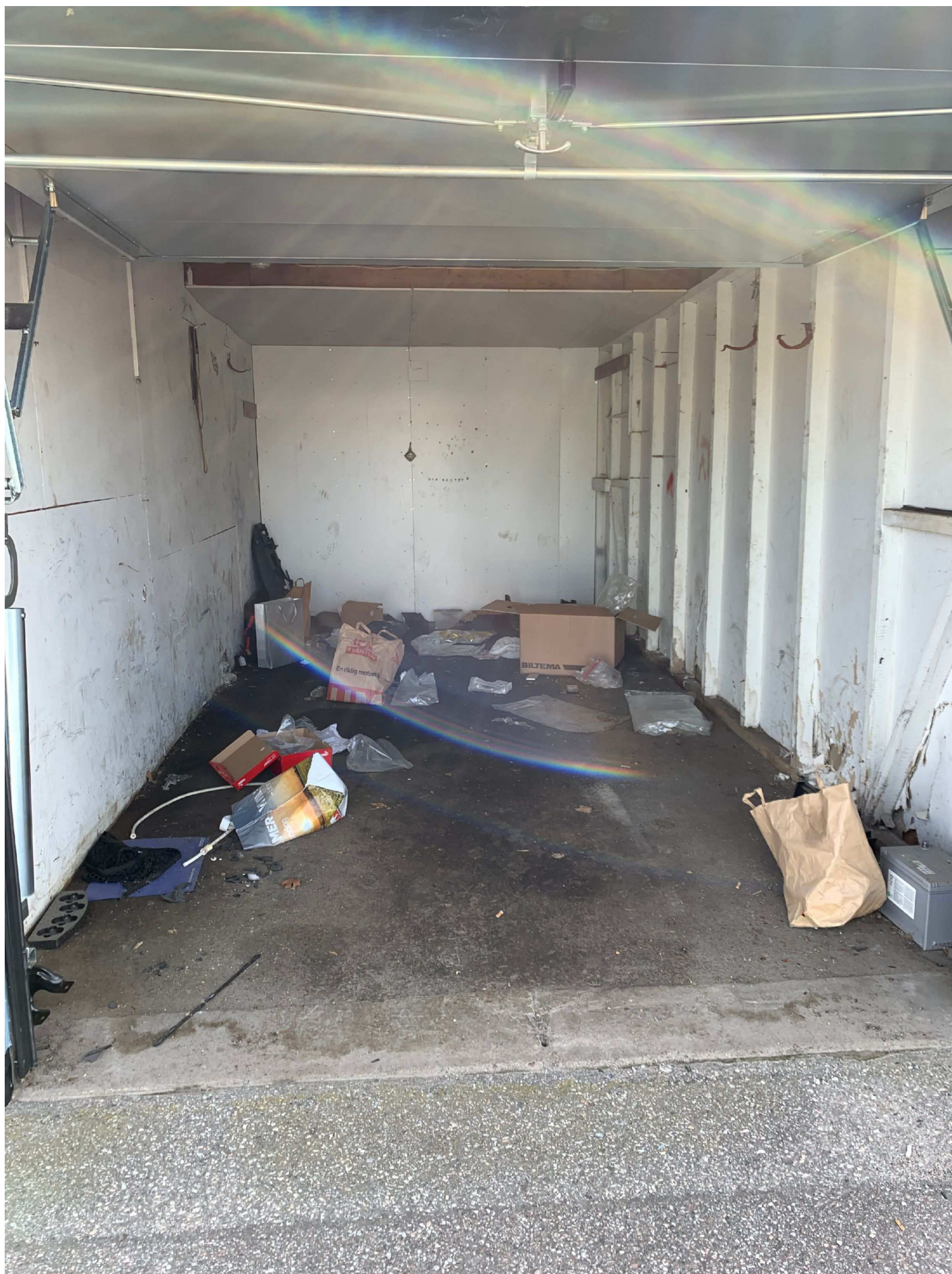
2. Garage 27 på Fasanstigen.
