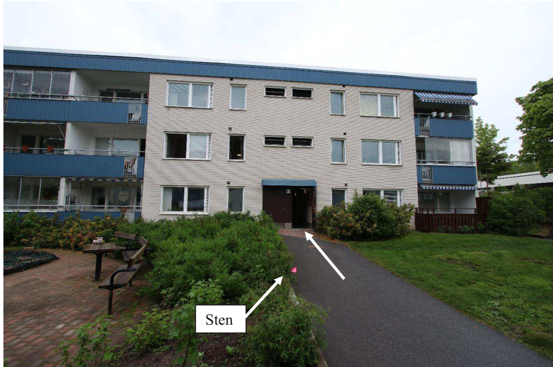
Figur 3. Fasaden, Mullbärsstigen 41, Kungsängen. Pil visar port in till trapphus. Rosa flagga visar BPU markering på sten (SM5991-6).
