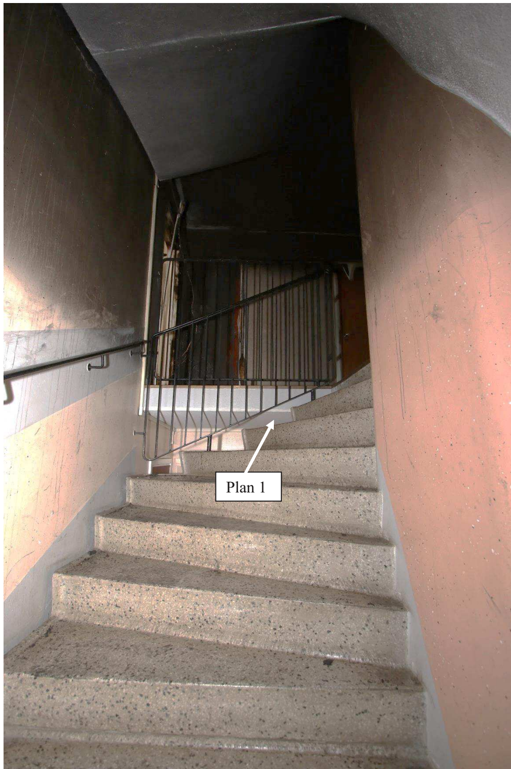
Figur 6. Trapphuset, trappan mellan bottenvåningen och plan 1.
