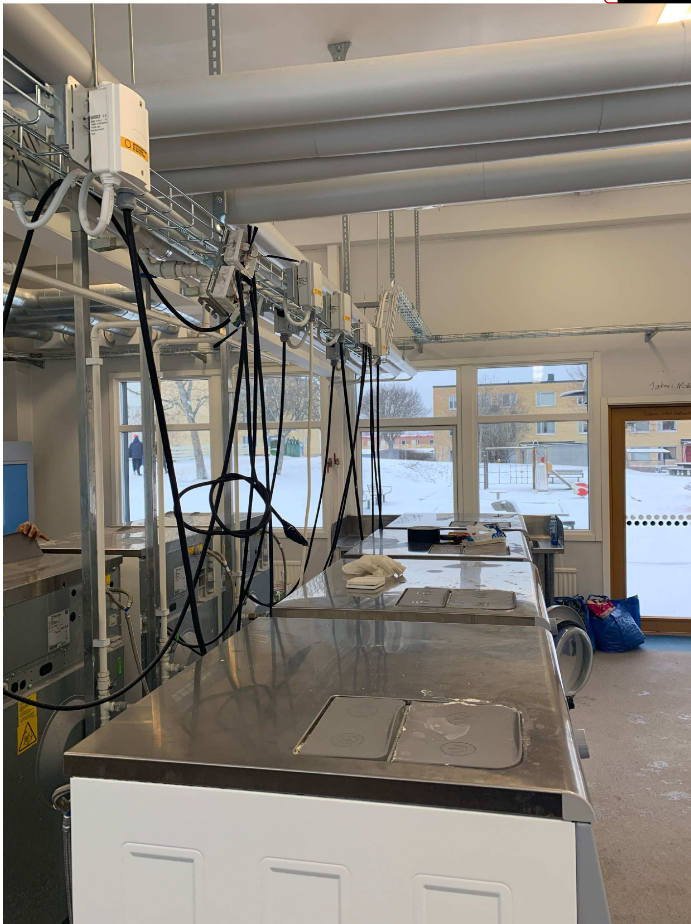
12. Öppnad panel ovanför tvättmaskin som Marko anträffades under.
