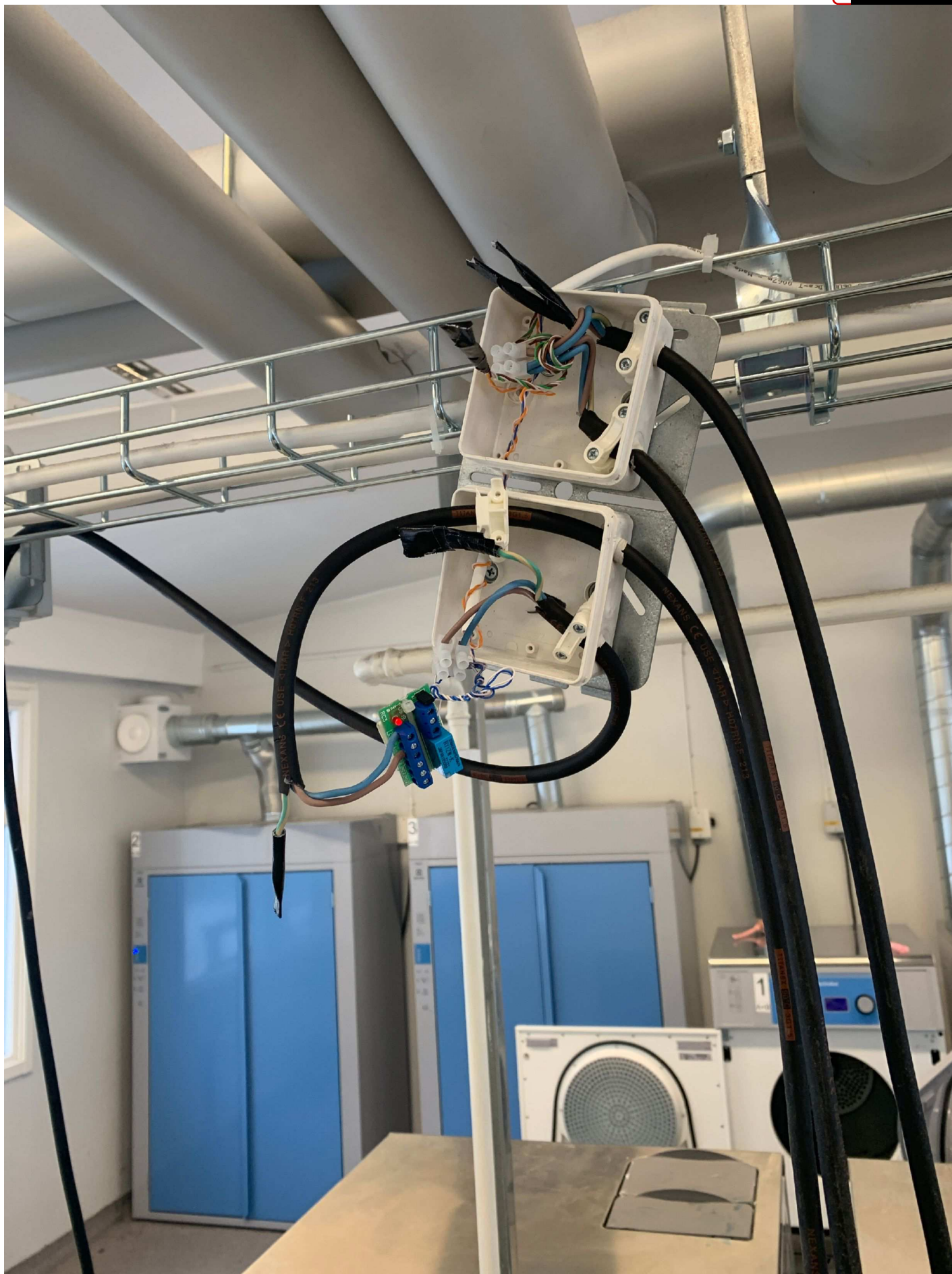
20. Öppnad panel ovanför tvättmaskin som Marko anträffades under, närbild.
