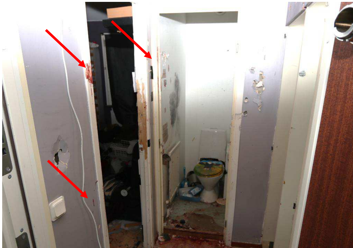
Figur 12. Hallen är fotograferad från ytterdörren. De röda pilarna markerar var blodbesudlingar på väggarna och dörrkarmarna iakttogs.
