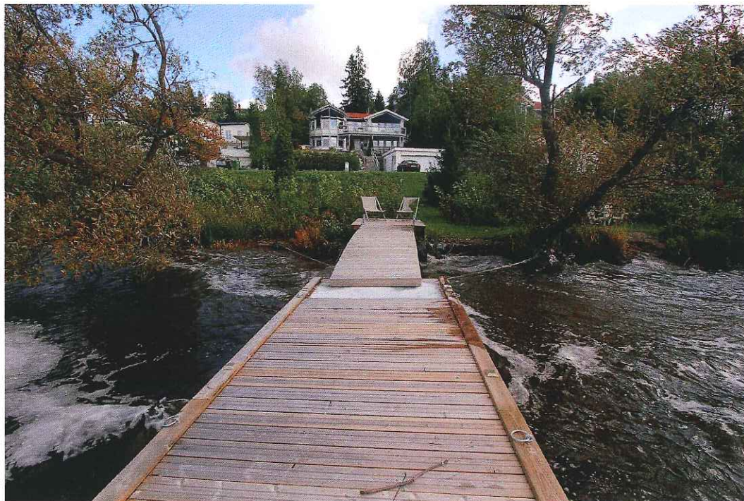
Bild 11 Husen på Munkholmsvägen fotograferade från brygga 3
