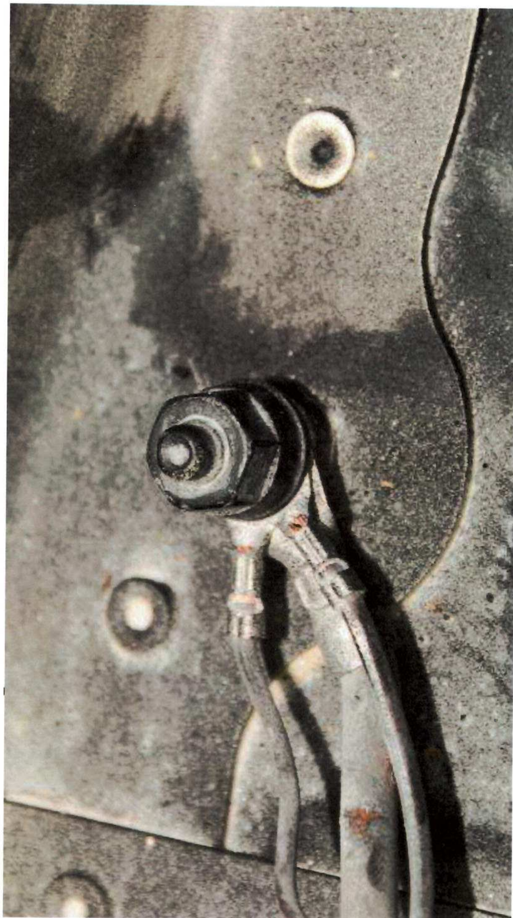
Fästmutter kablage. Röd pil på föregående bild
