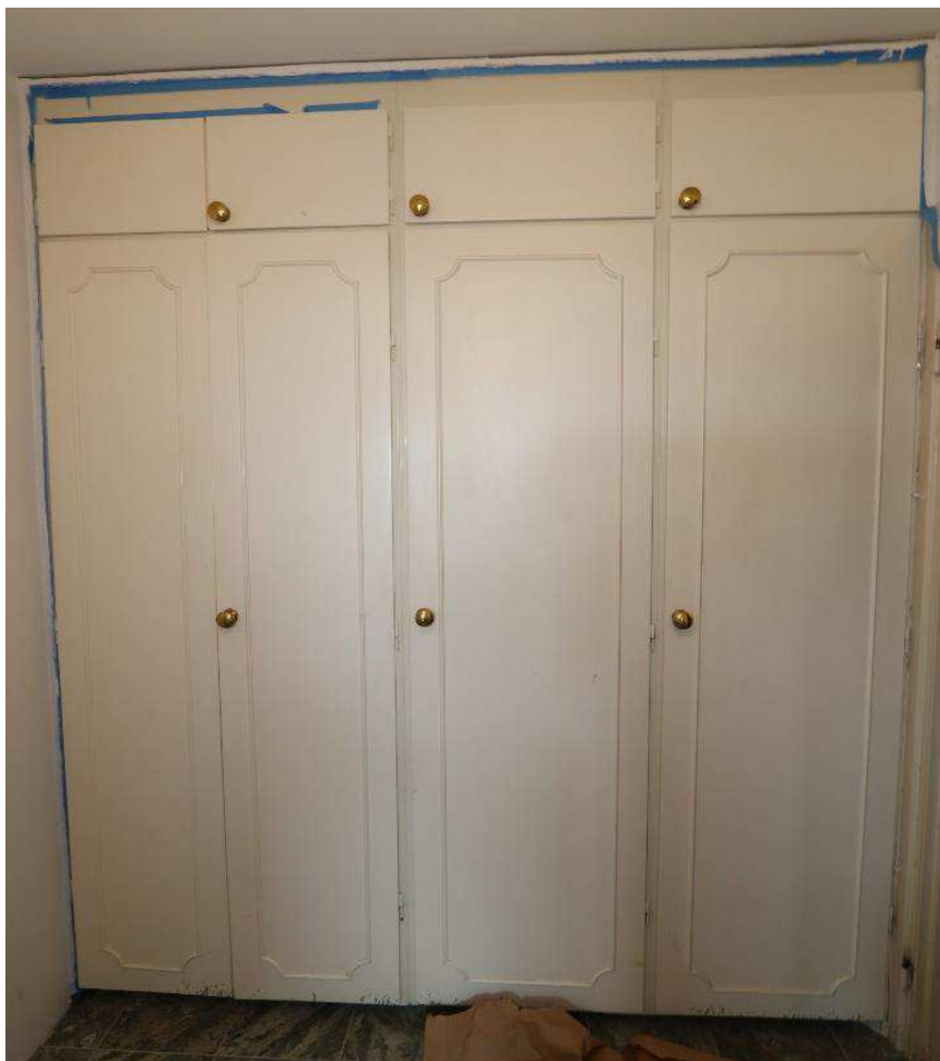
Figur 9. Garderober i hallen innanför ytterdörren.
