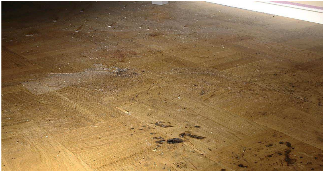
Figur 30. På golvet under sängen iakttas smuts och damm och svepande dragningar/avtorkningar.
