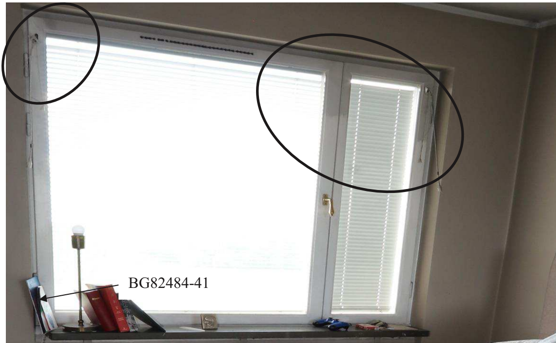
Figur 46. I fönstret finns en tavla (BG82484-41) med bl a ett fotavtryck. I de svarta markeringarna finns avtorkat sot.
