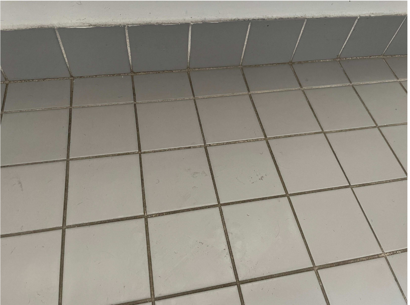
5. Detaljbild golv i toalett
