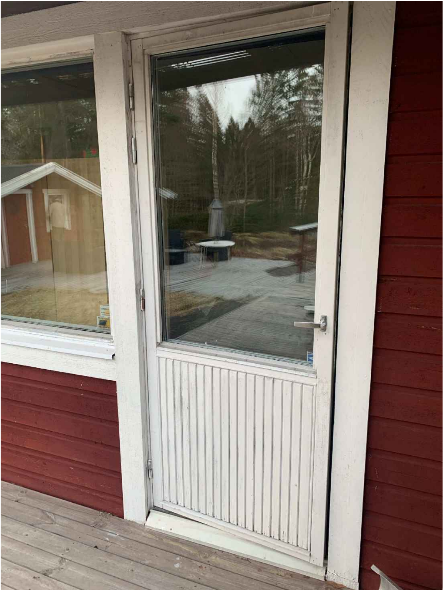
1. Entrédörr(olåst) till rum som sitter ihop med boningshuset med egen ingång.
