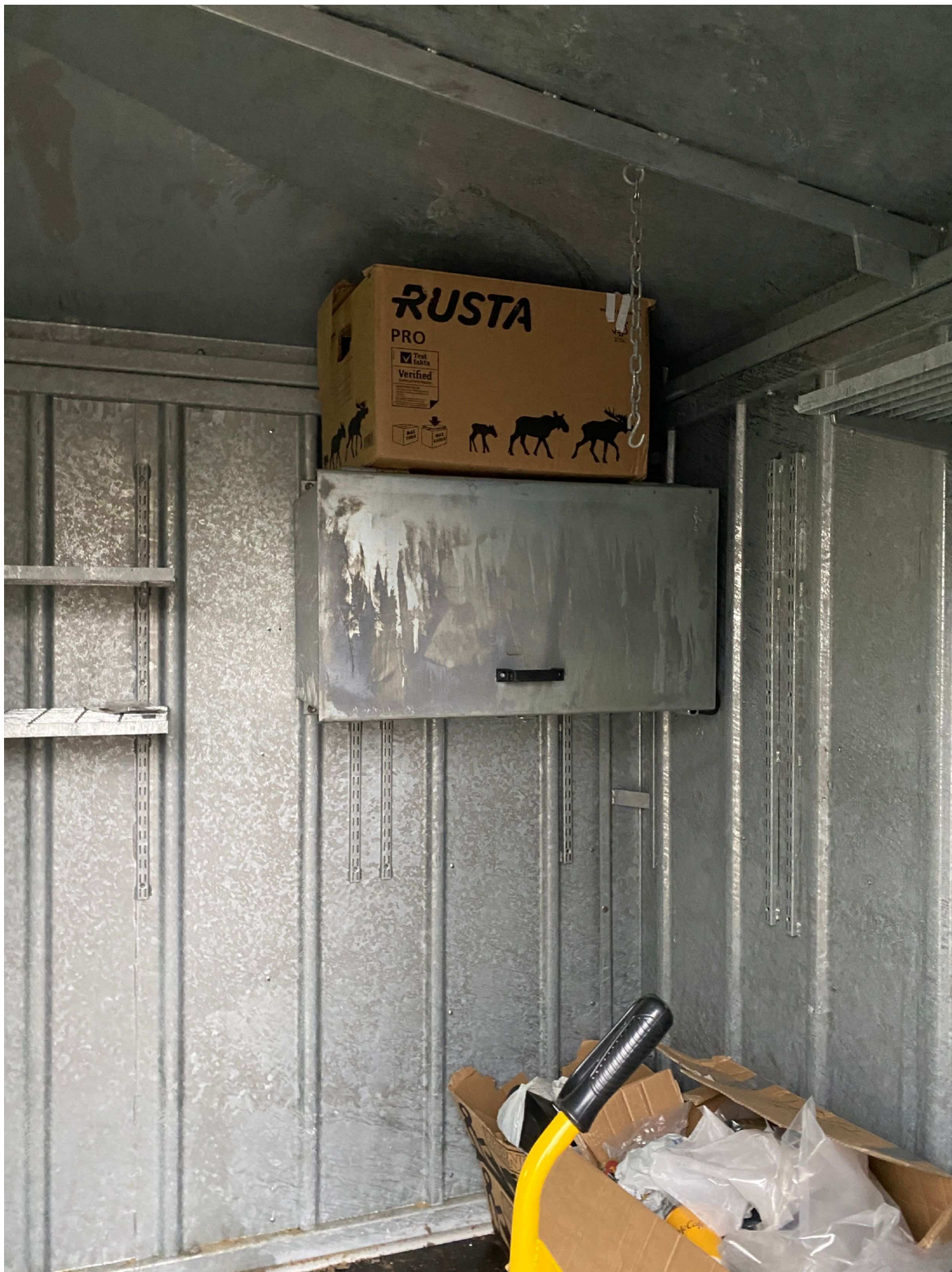
2. Plåtskåpet på väggen inne i containern med bla två plastlådor BG 6719 p 7 och 9
