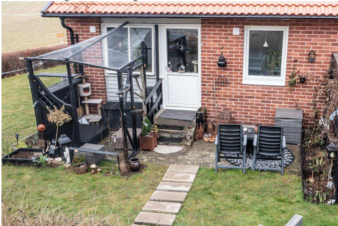
Figur 22. Altanen på baksidan av huset.
