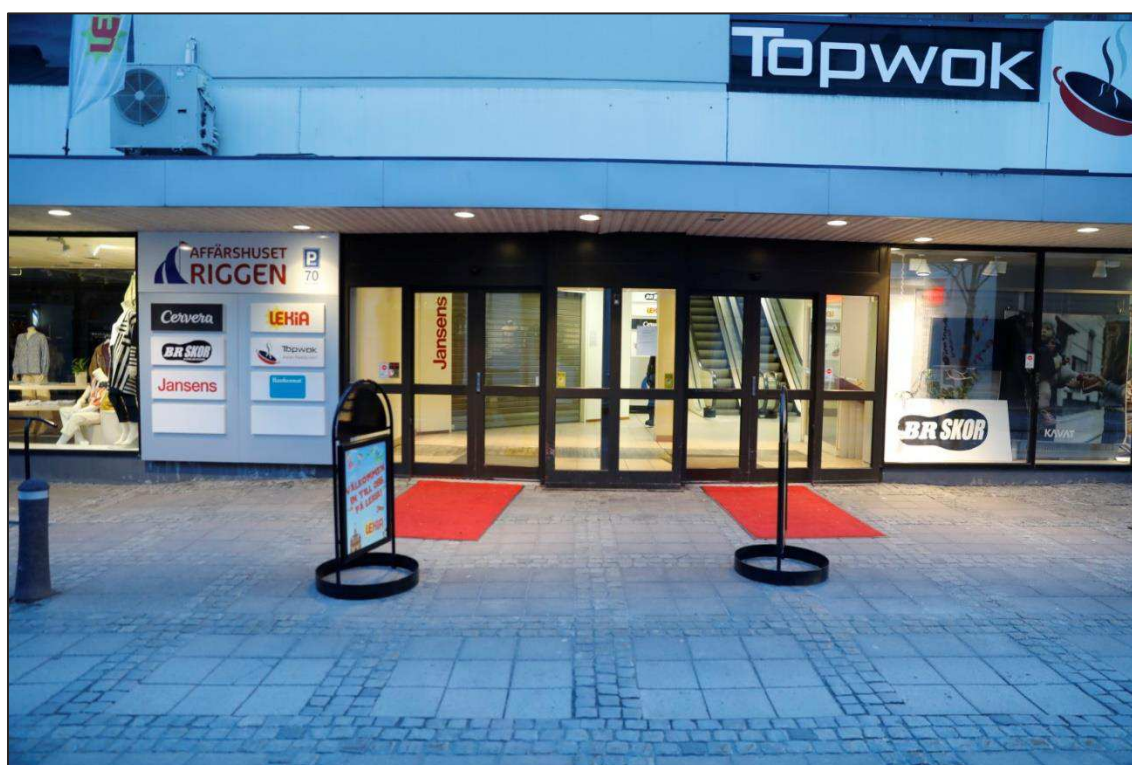
Figur 4 Entrédörrarna till affärshuset Rikken. Omedelbart till höger innanför entrén ses trappan som leder ner till en sluss och vidare in till parkeringsplanet under affärshuset.
