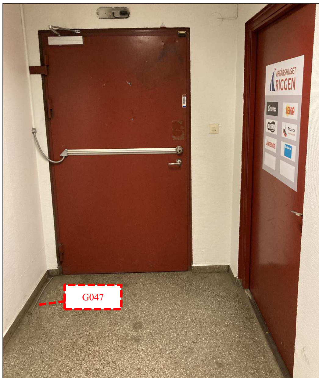
Figur 22 Foto taget från den inre väggen i slussen. Dörren rakt fram är ut mot garaget. Dörren till höger är ut i trappen. Markering visar gängstången G047.
