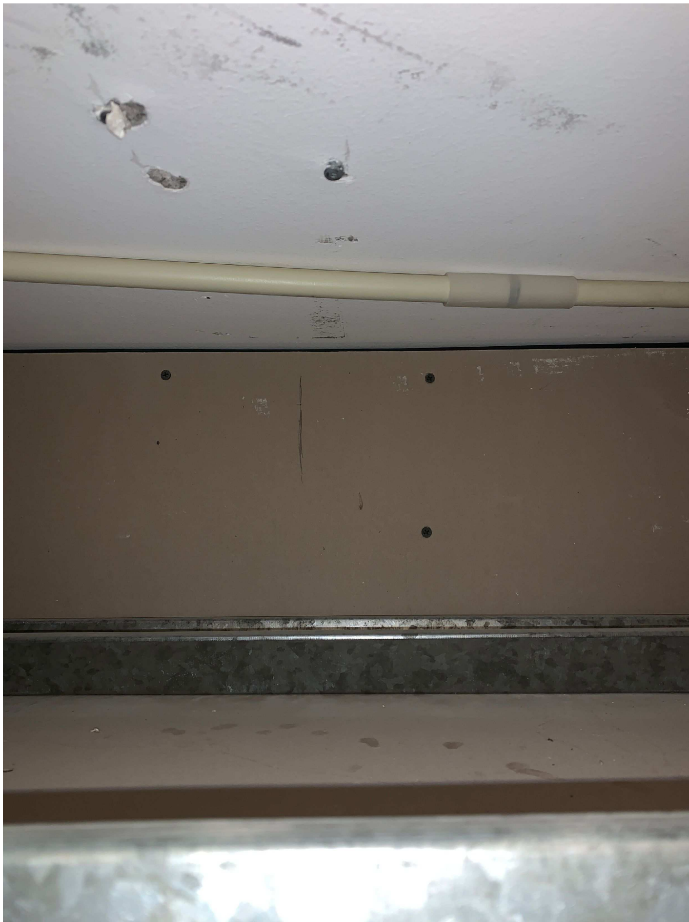
8. Visar utrymmet runt luckan i badrummet.
