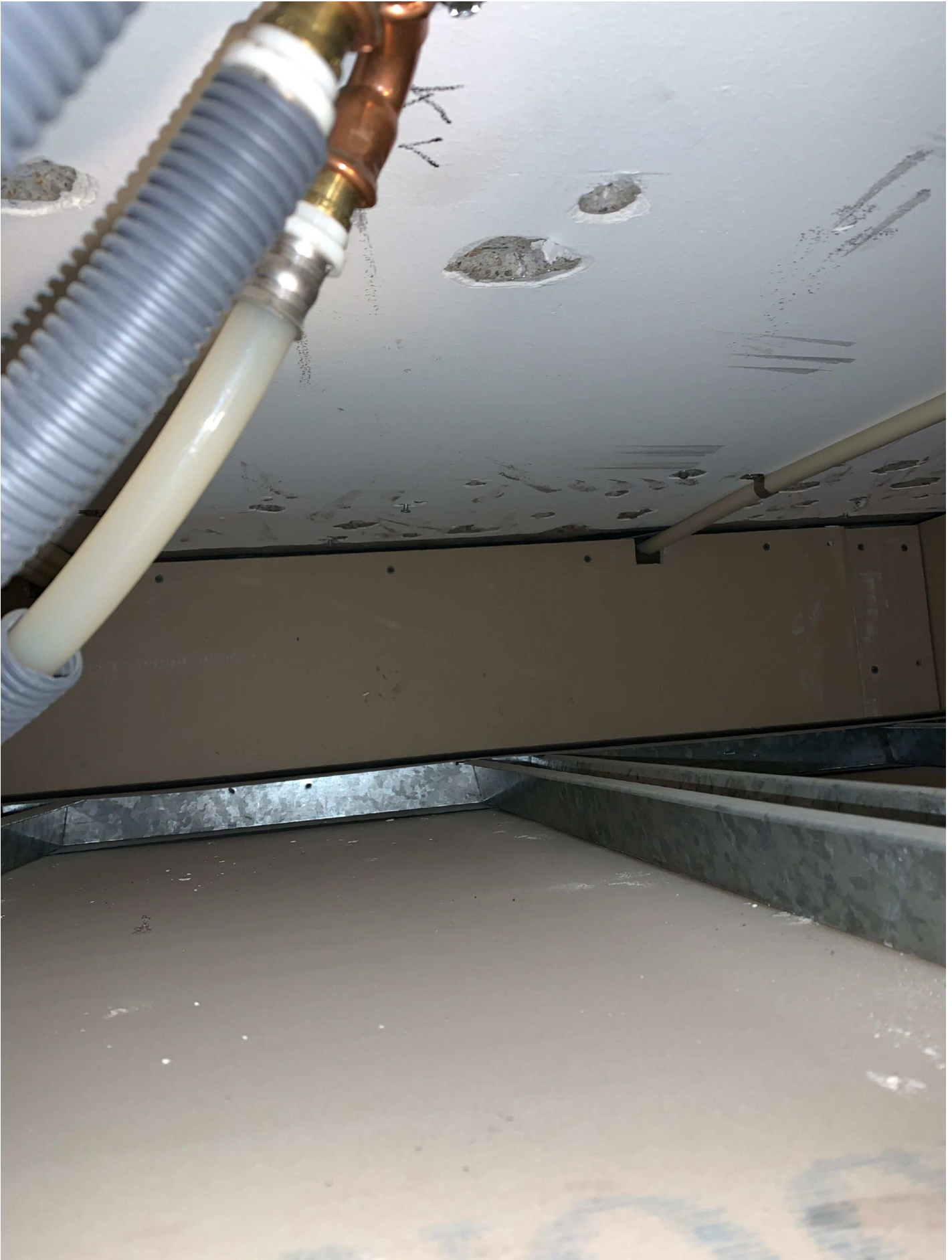
9. Visar utrymmet runt luckan i badrummet.
