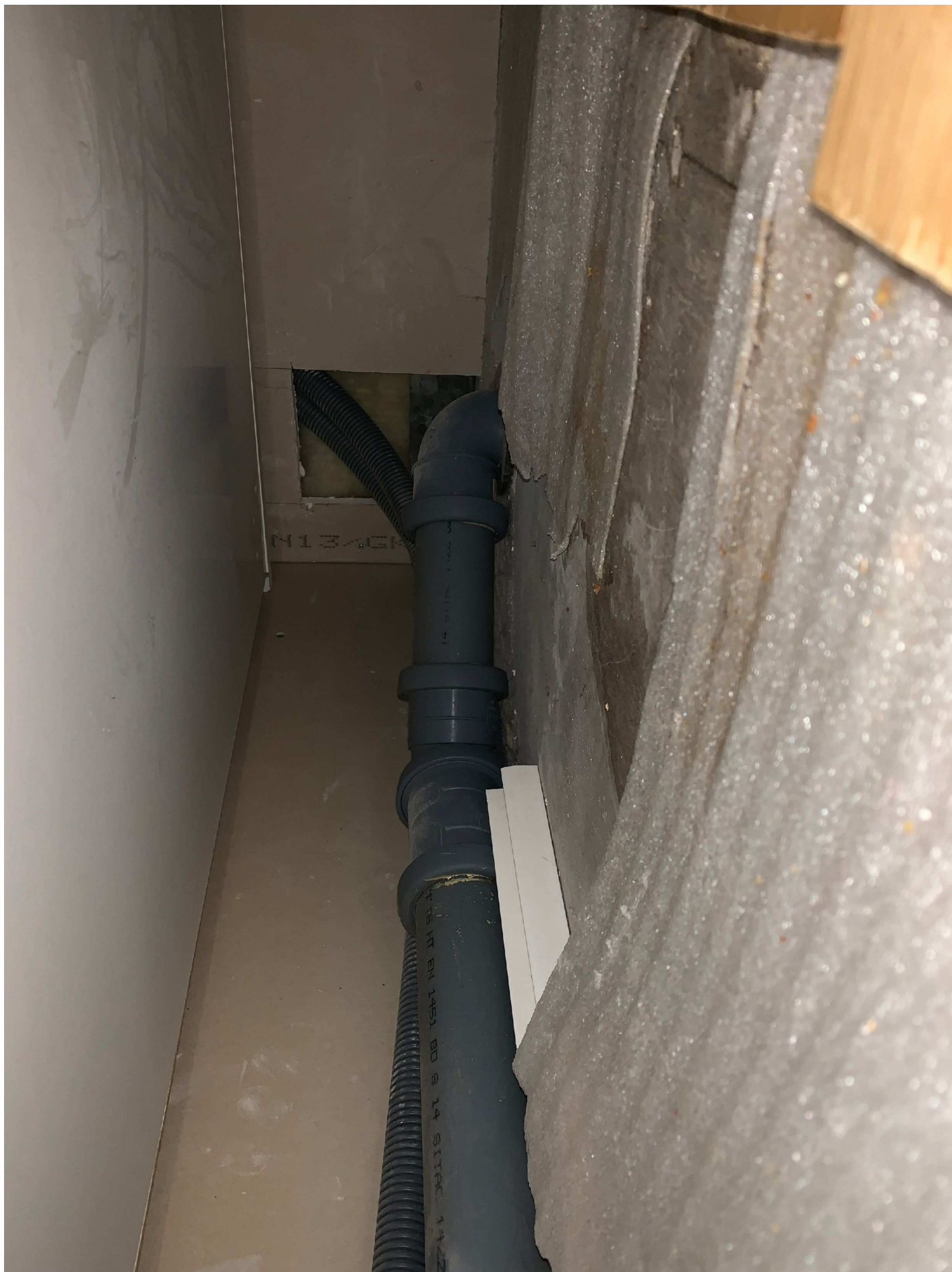
4. Visar utrymmet bakom sockeln, på högersida.
