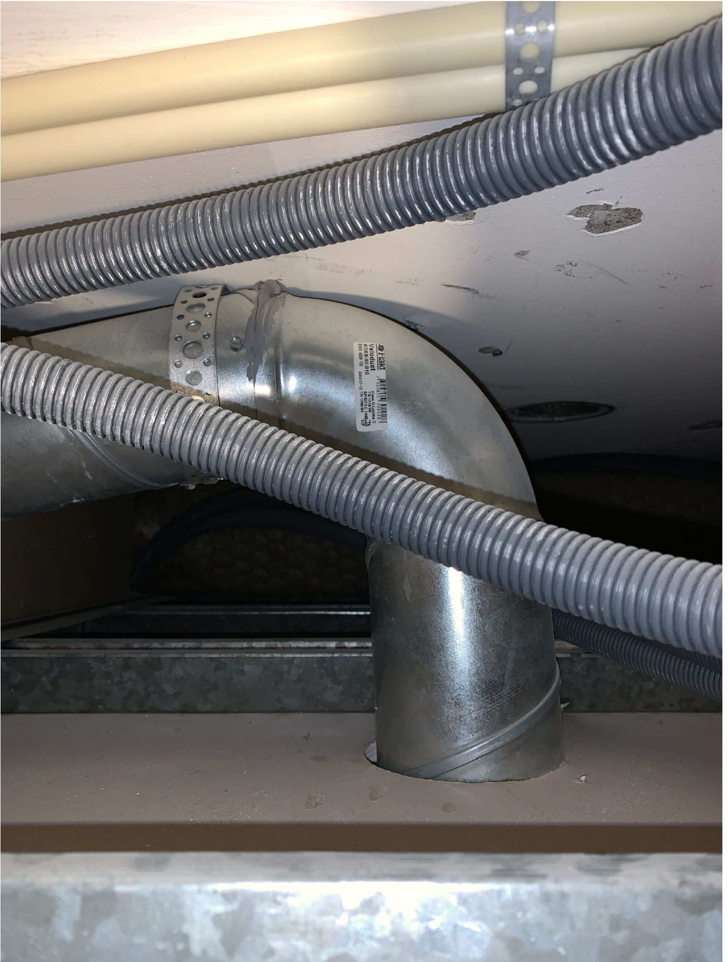
7. Visar utrymmet runt luckan i badrummet.
