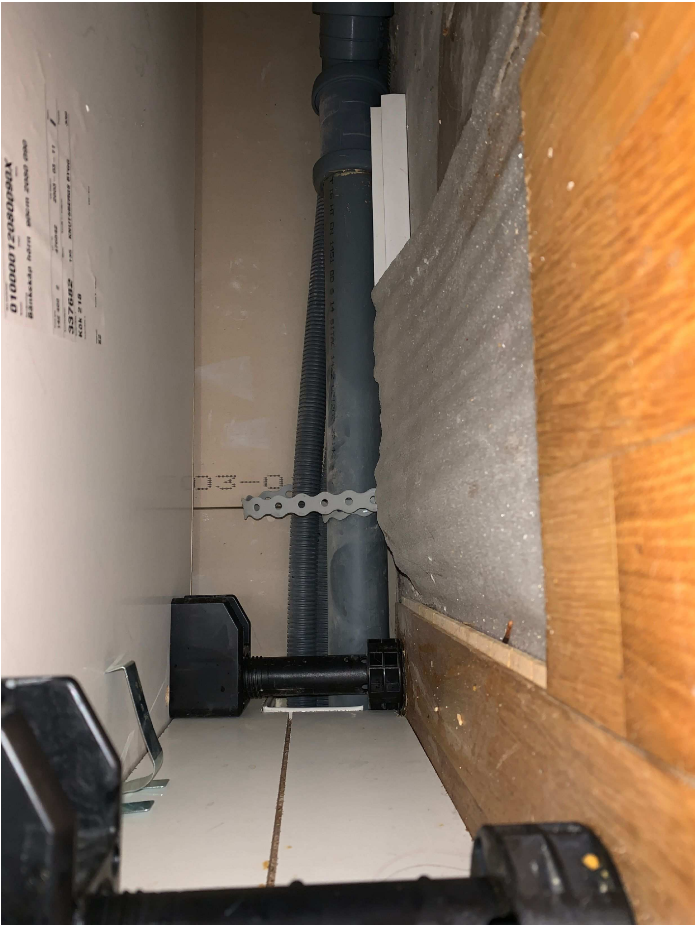
3. Visar utrymmet bakom sockeln, raktfram.
