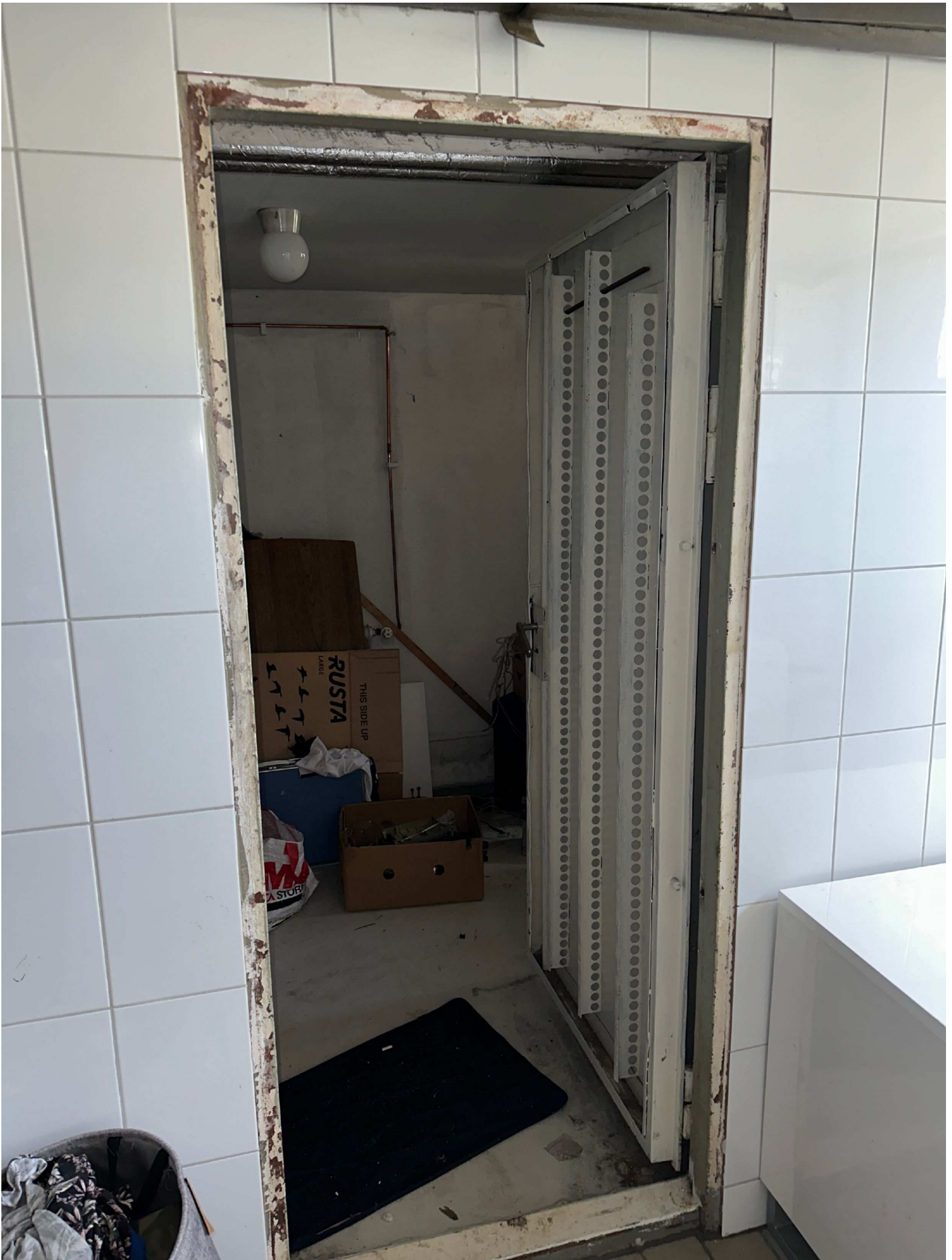
26. Kattkroksvägen 71-6, Asarum. Dörr in till pannrum i bottenplan. Foto taget av J Mejegård
