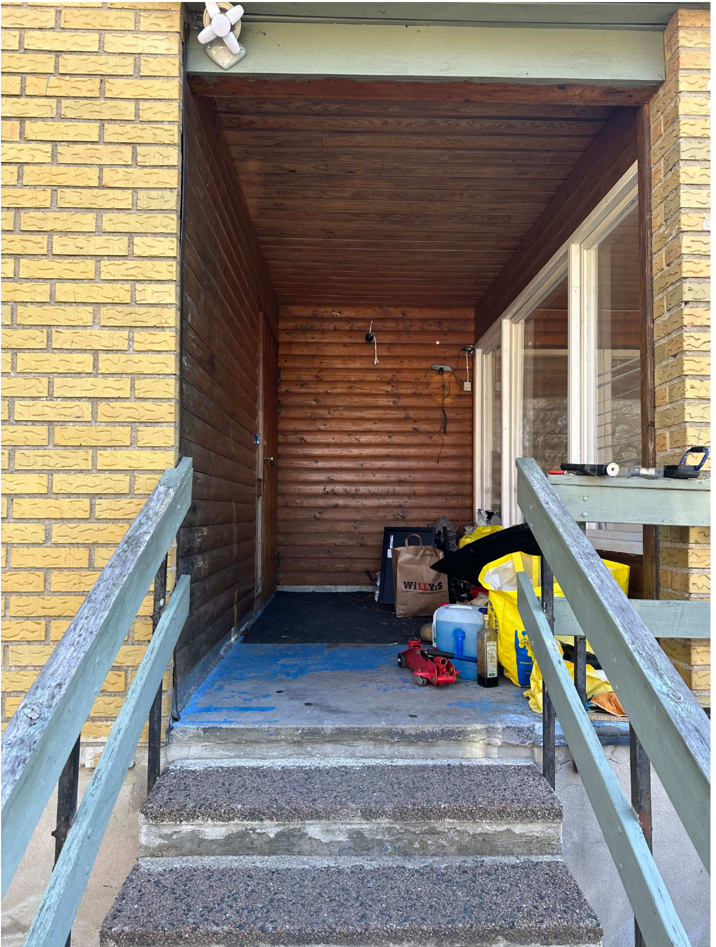
2. Kattkroksvägen 71-6, Asarum. Trappen upp till huvudentrén som är till vänster i i bild. Foto taget av J Mejegård
