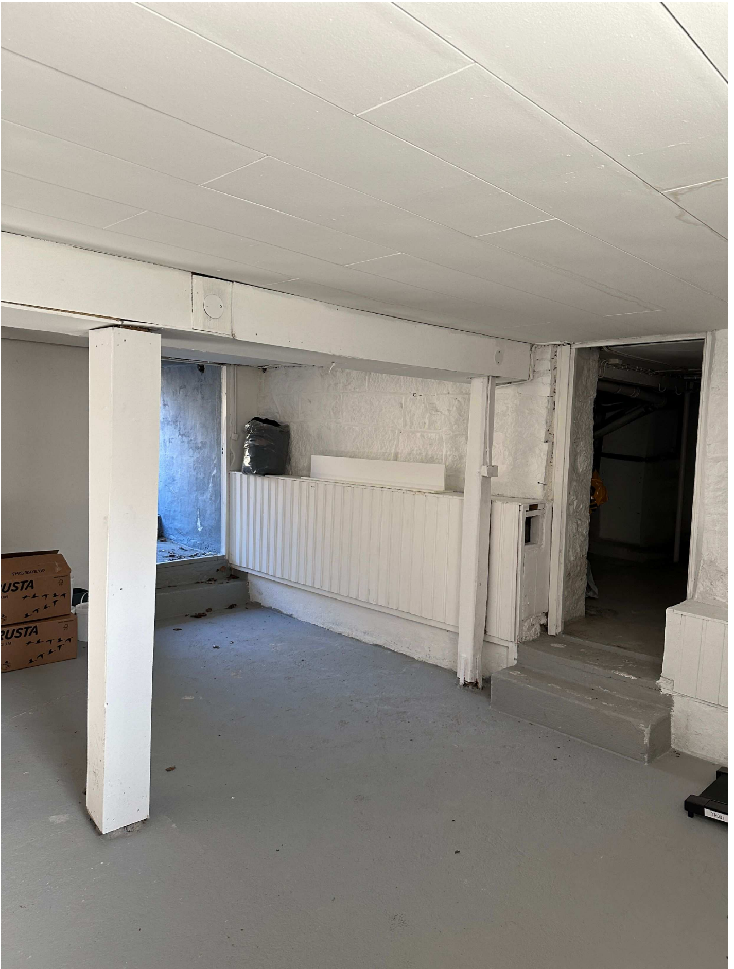
14. Foto taget av A.Cimerman. Stora rummet i källaren.
