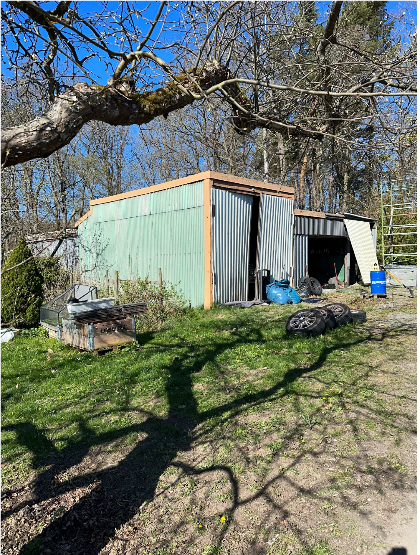
1. Kattkroksvägen 71-6, Asarum. Förrådsbyggnad/Garage mitt emot huvudentrén. Foto taget av J Mejegård
