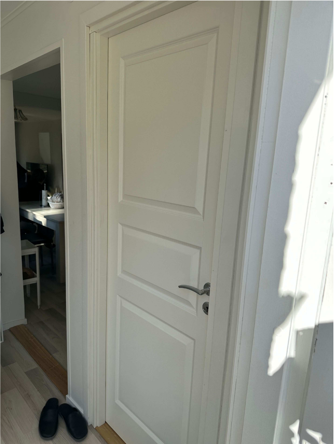
16. Foto taget av A.Cimerman. Hallen. Dörren till höger kom man in till föräldrarnas sovrum (blockerad från andra hållet med garderober). Efter dörren till höger kom man in till köket och vardagsrummet.
