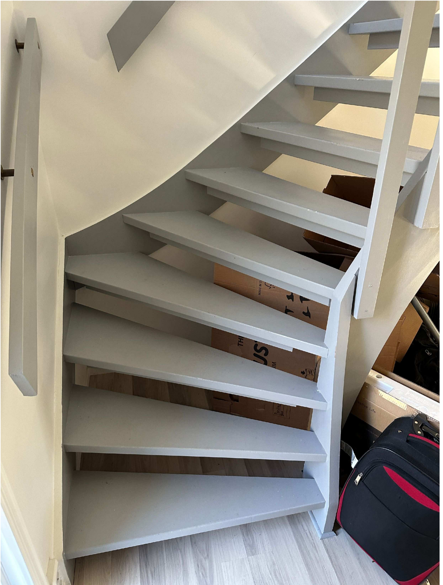
32. Foto taget av A.Cimerman. Trappan upp till översta våningen.
