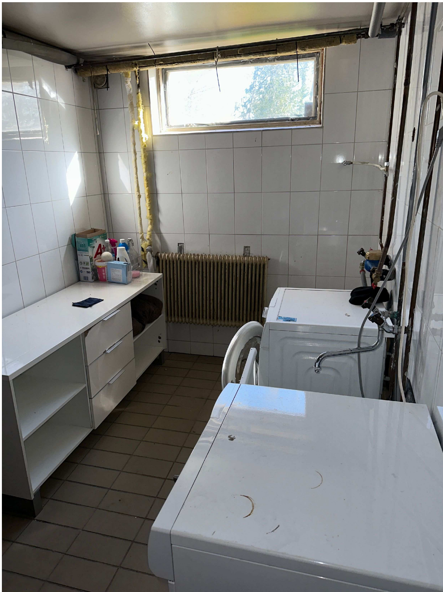
25. Kattkroksvägen 71-6, Asarum. Tvättstuga i bottenvåningen. Foto taget av J Mejegård
