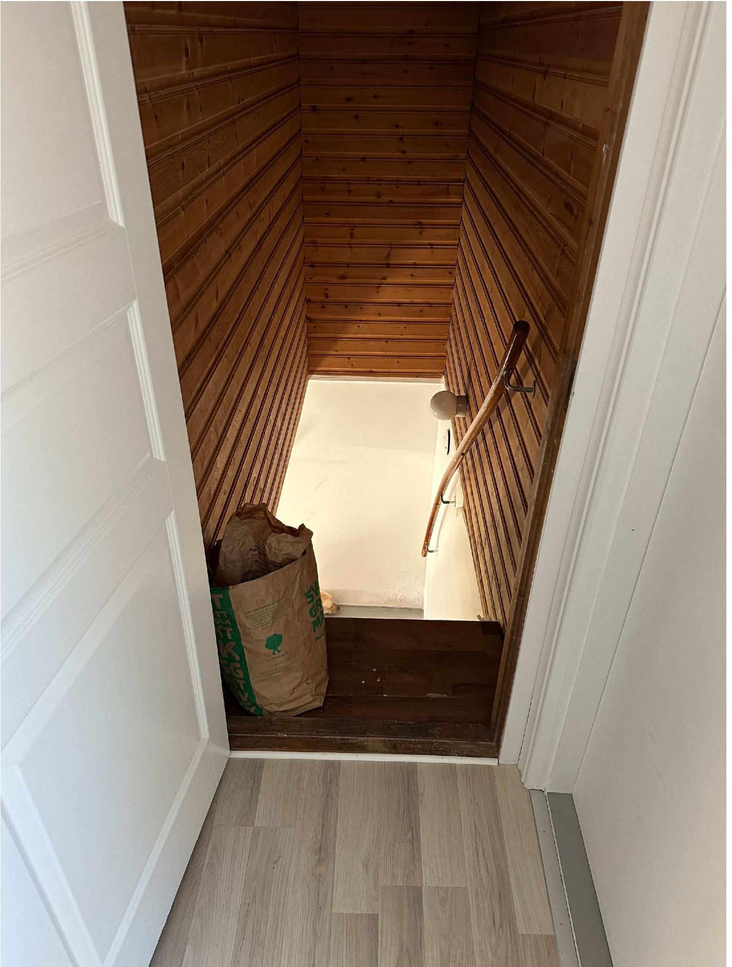
31. Foto taget av A.Cimerman. Trappan ner till källaren.
