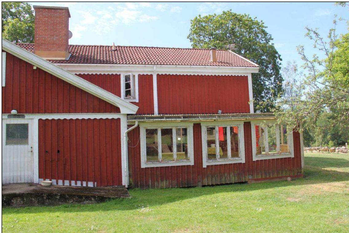
Figur 5 Fastighetens norra sida.
