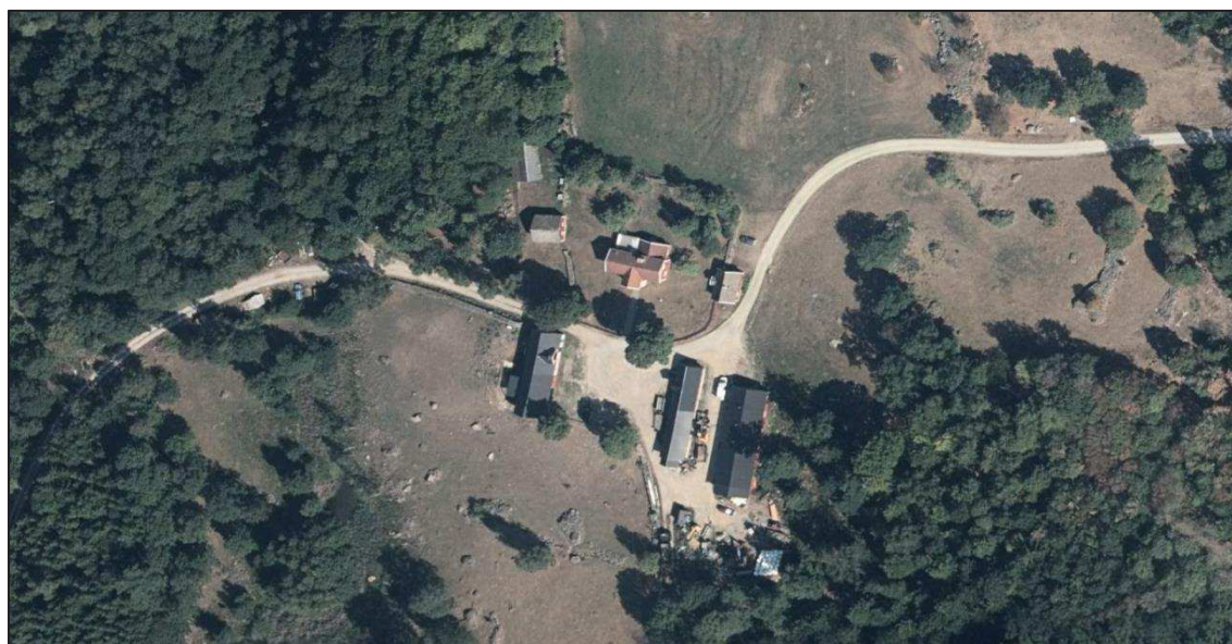
Figur 2 Översiktsbild samtliga byggnader på Bergsmåla 109.
