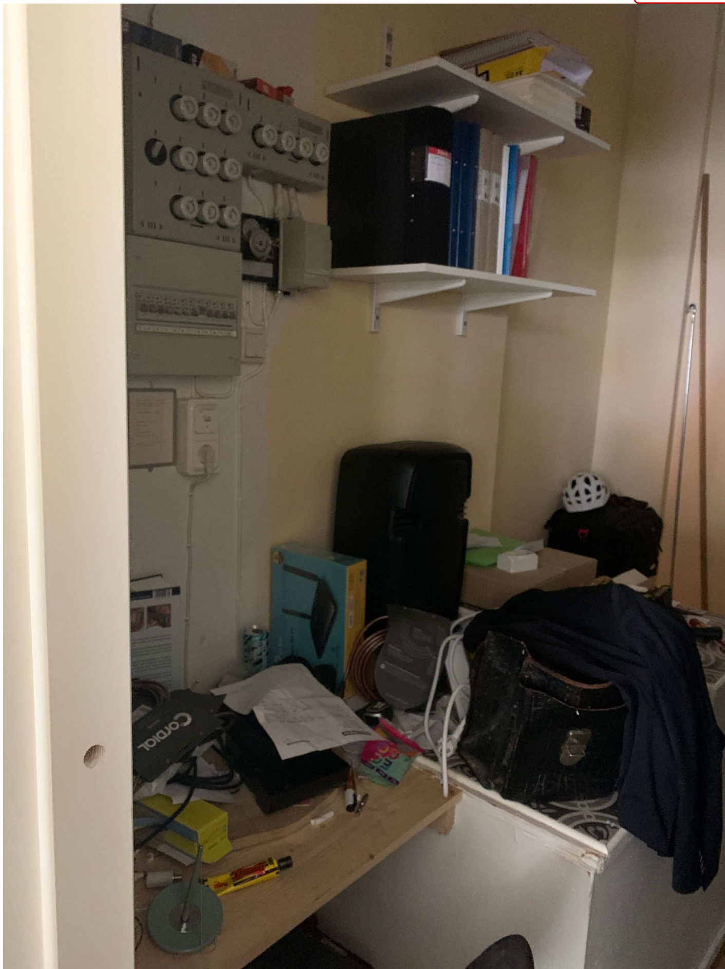
7. bild mellanrummet ner mot källartrappen
