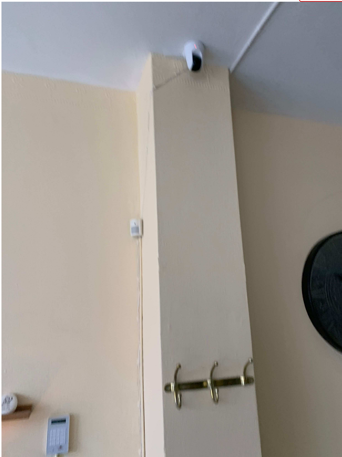
3. kameraövervakning BG92151-3 syns uppe i taket.
