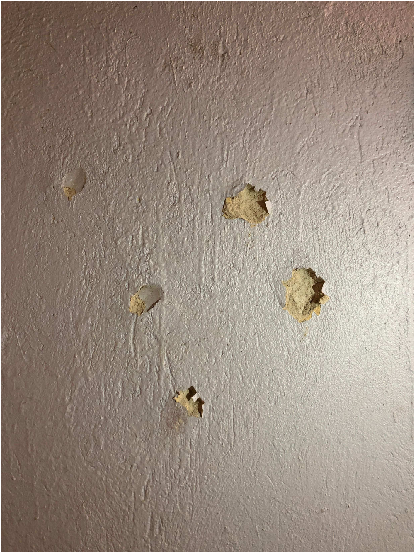
3. Närbild verktygshål i väggen ute i källargången.
