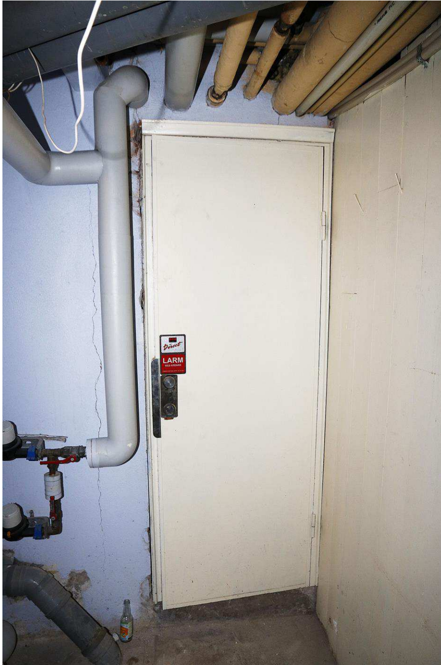
Figur 16. Källardörr, vy från utsidan
