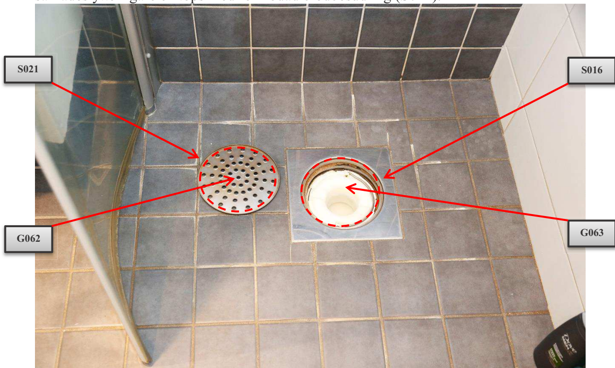
Figur 70. Golvbrunnen i duschen, metallsil och vattenlås (G062-G063), plats för förmodade blodbesudlingar (S016, S021).
