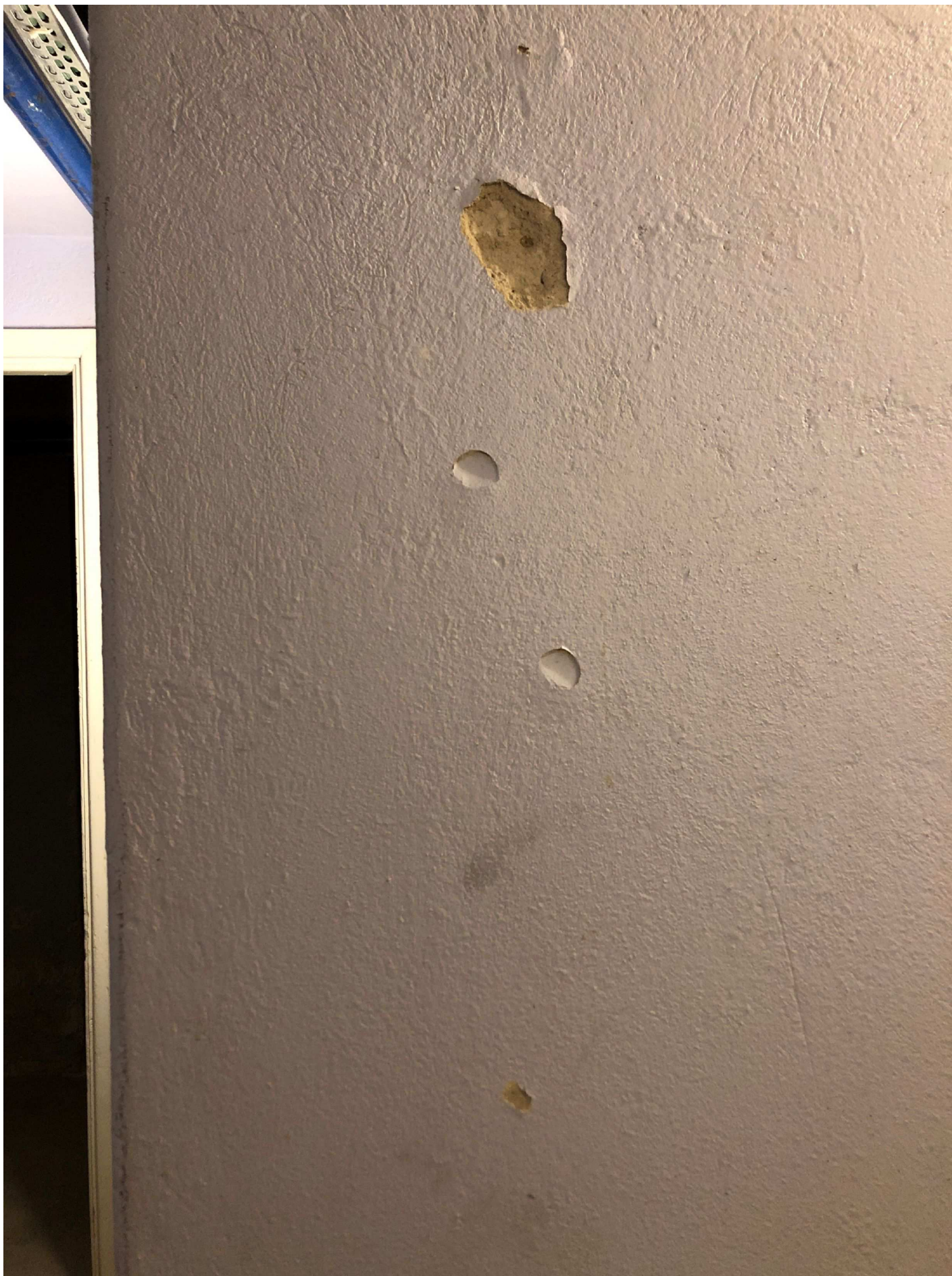
16. Närbild på verktygshålen i källargången bort till vänster.
