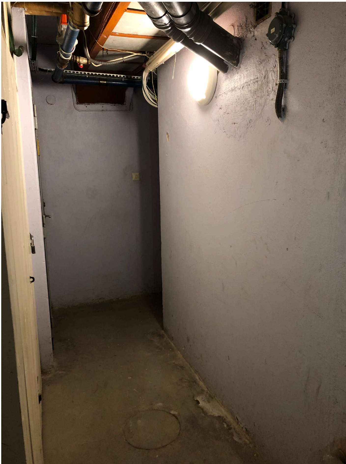
13. Översiktsbild åt vänster i källargången.
