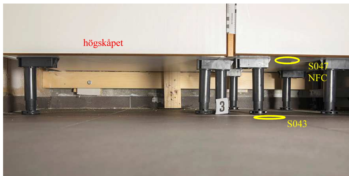
Bild 21. Under sidan av högskåpet när sockeln är borttagen.
