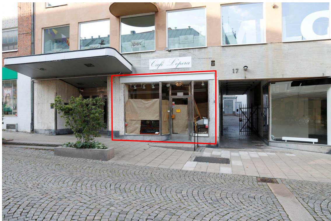
Figur 2. Borgmästaregatan 17, Karlskrona (brunpappret har satts upp som insynsskydd vid genomförandet av husrannsakan)
