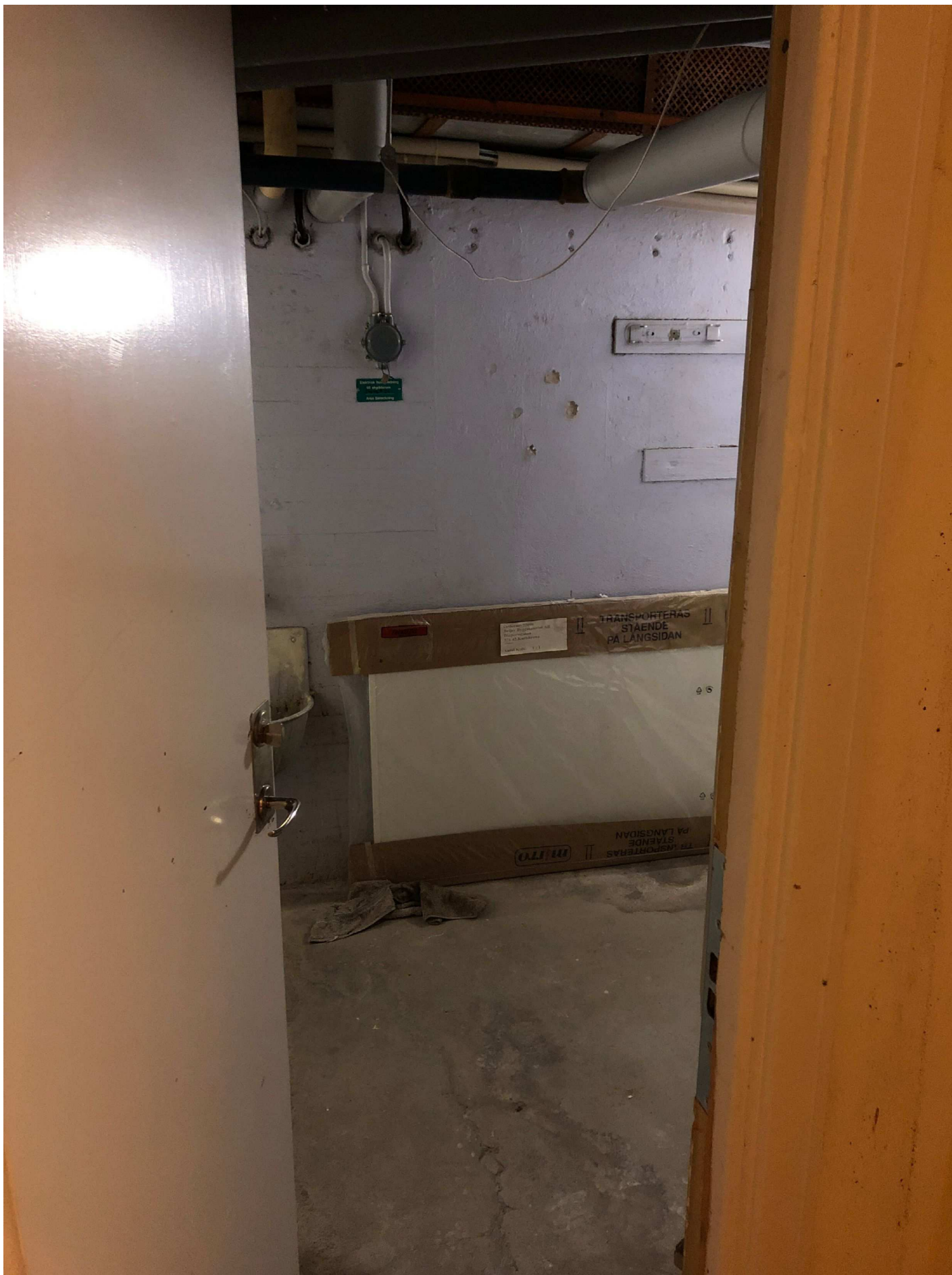
2. Översiktsbild - verktygshål i väggen ute i källargången.
