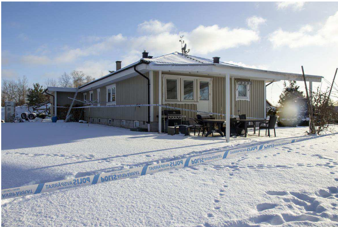
Figur 4. Husets västra gavel och bakre långsida.
