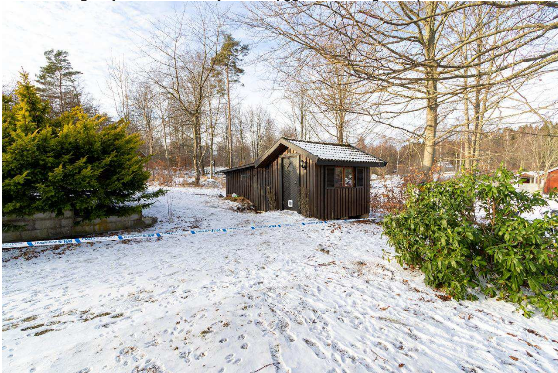
Figur 7. Fristående inredd byggnad.
