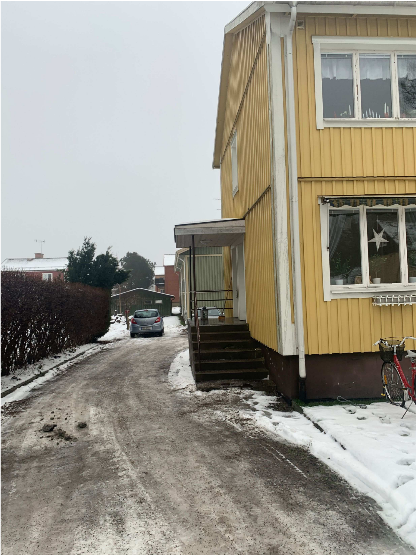
2. Uppfart till Vintergatan 16. Runt gaveln finns utbyggnaden där branden startade.
