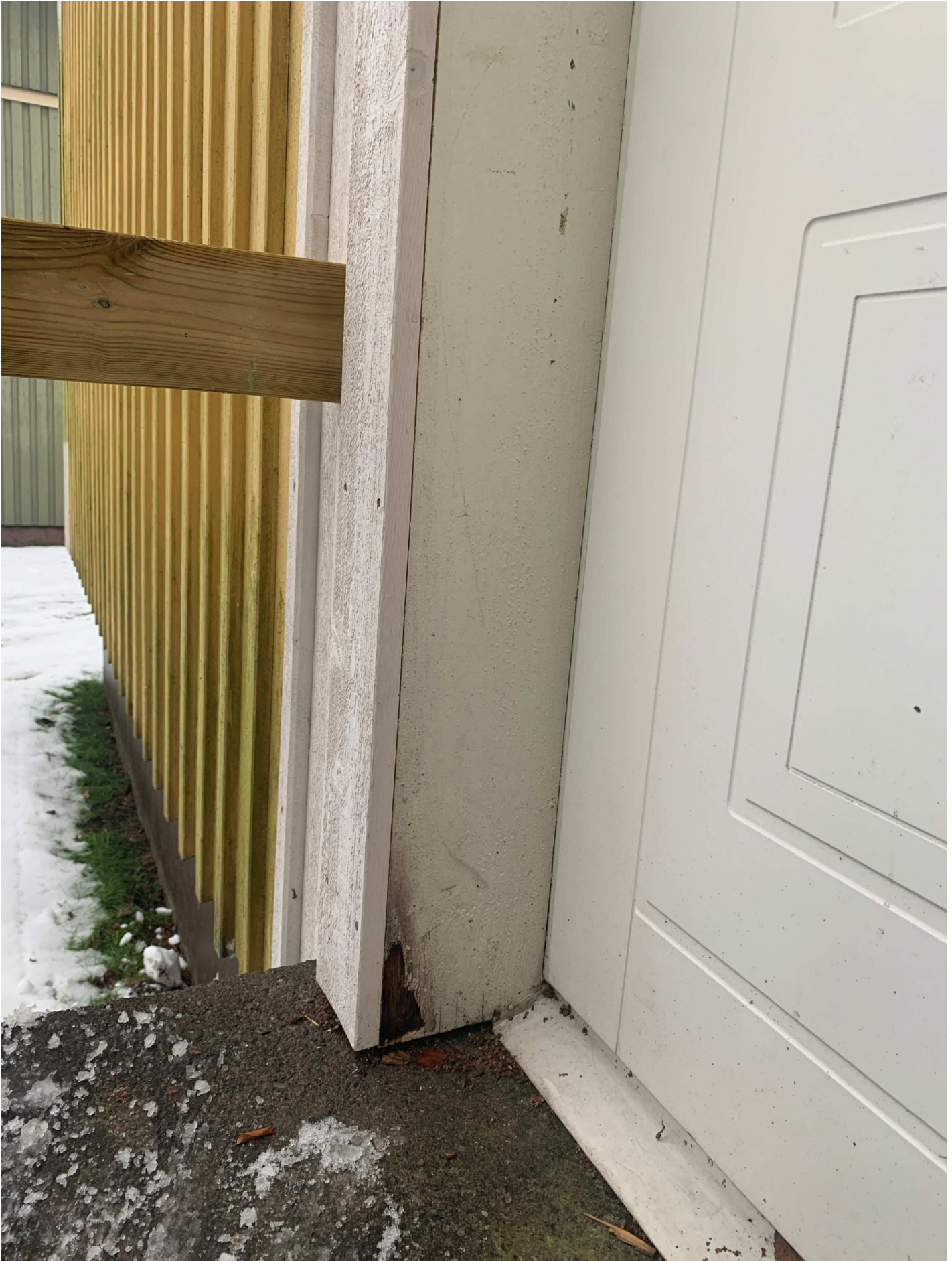
5. Vänstra dörrfodret byttes ut efter branden. Man se dock mindre skador längst ner till vänster.
