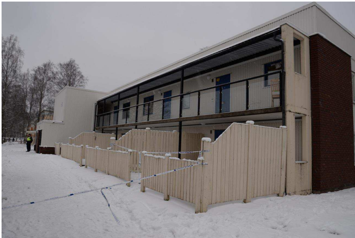
Bild 2. Södra delen av huskroppen med adress Lasarettsgatan 33, Vetlanda
