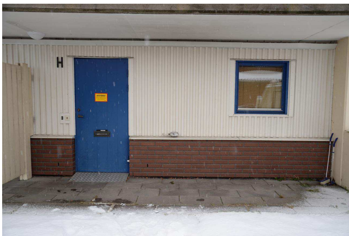
Bild 4. Entrédörr o köksfönster till den för undersökningen aktuella lägenheten.
