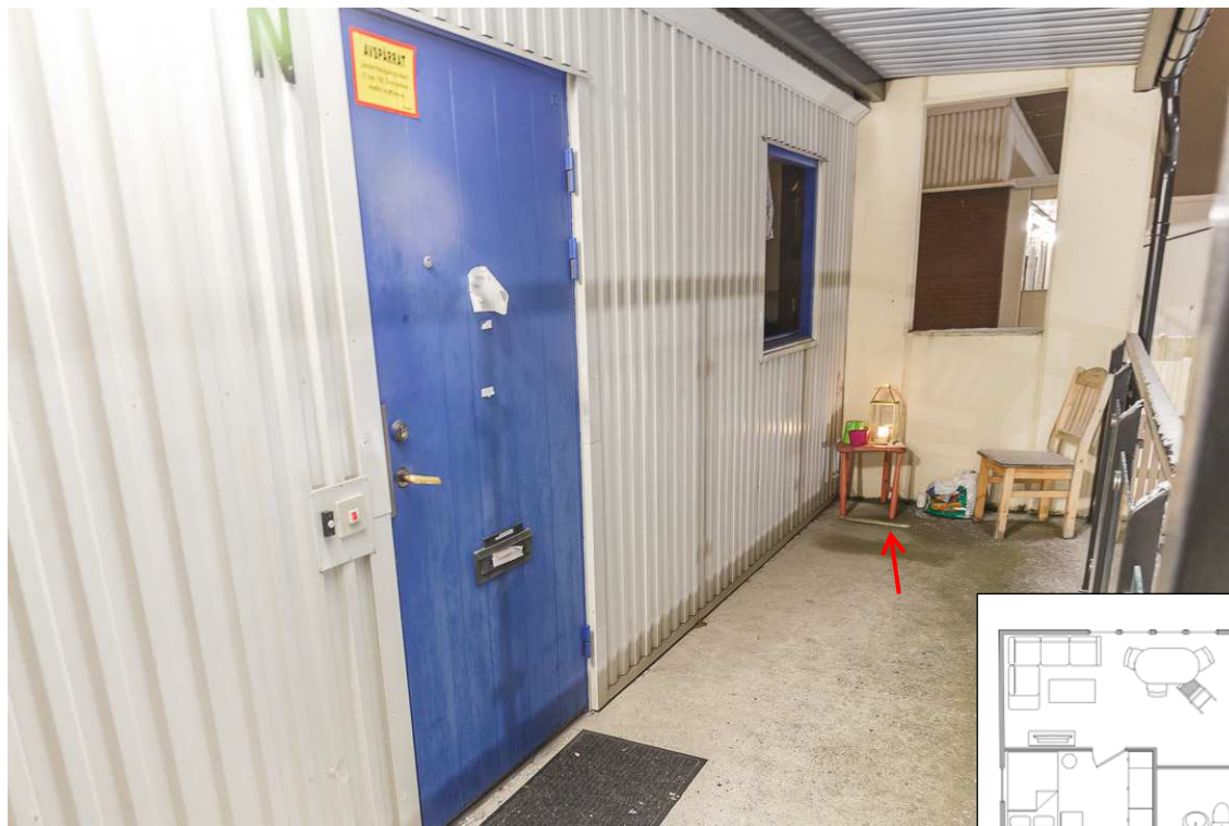
Bild 6. Loftgången med lägenhetsdörren till Lasarettsgatan 33N och köksfönstret. Pilen markerar en del av en träsits som låg intill pallen. Pilen i den infällda skissen markerar fototäkningen.
