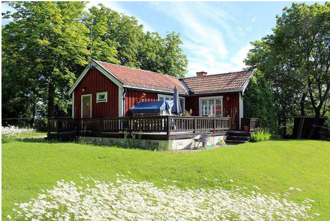
Bild 2. Fastighetens södra sida, entrén på västra gaveln och altanen.
