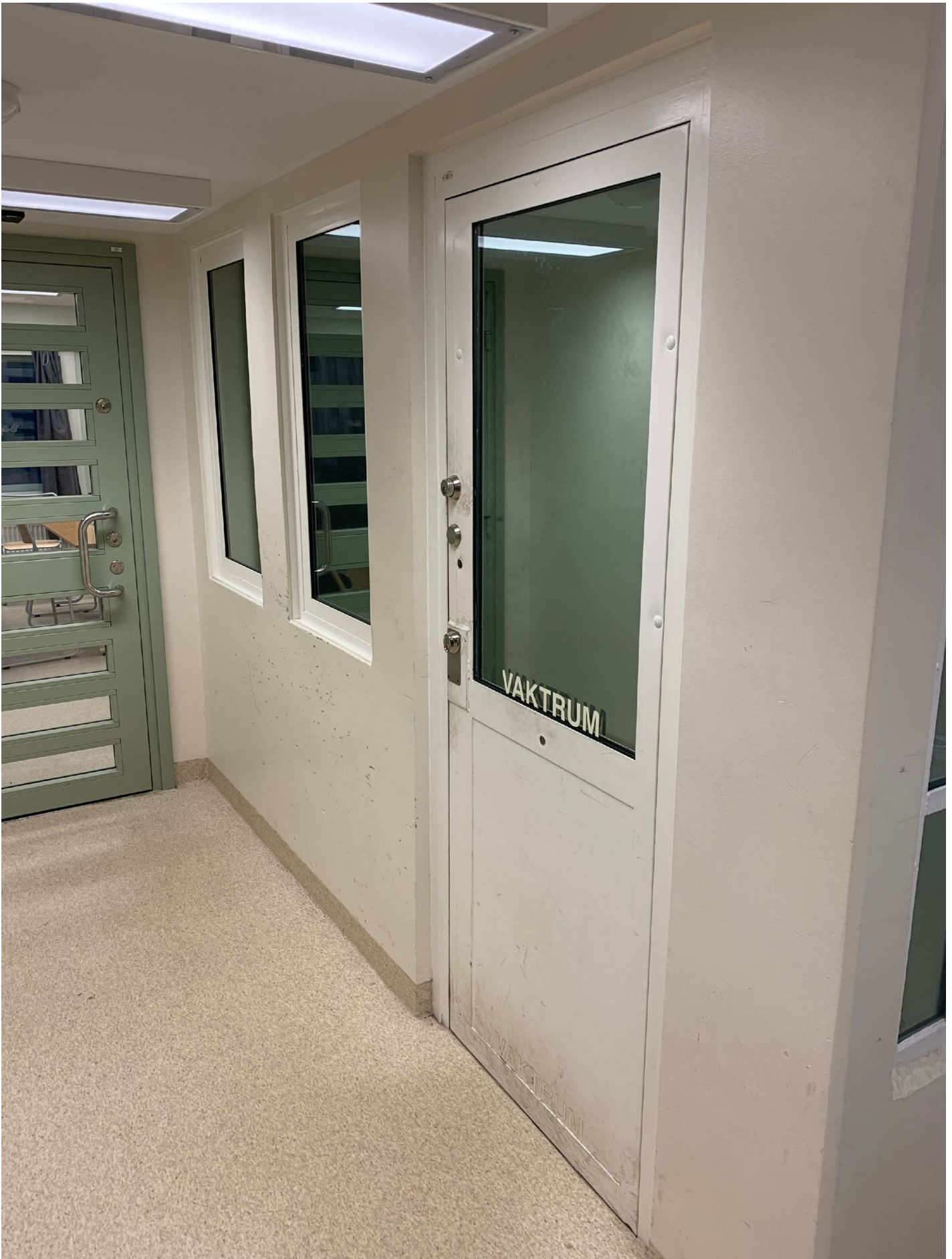
4. Ingången/dörren till vaktrummet.
