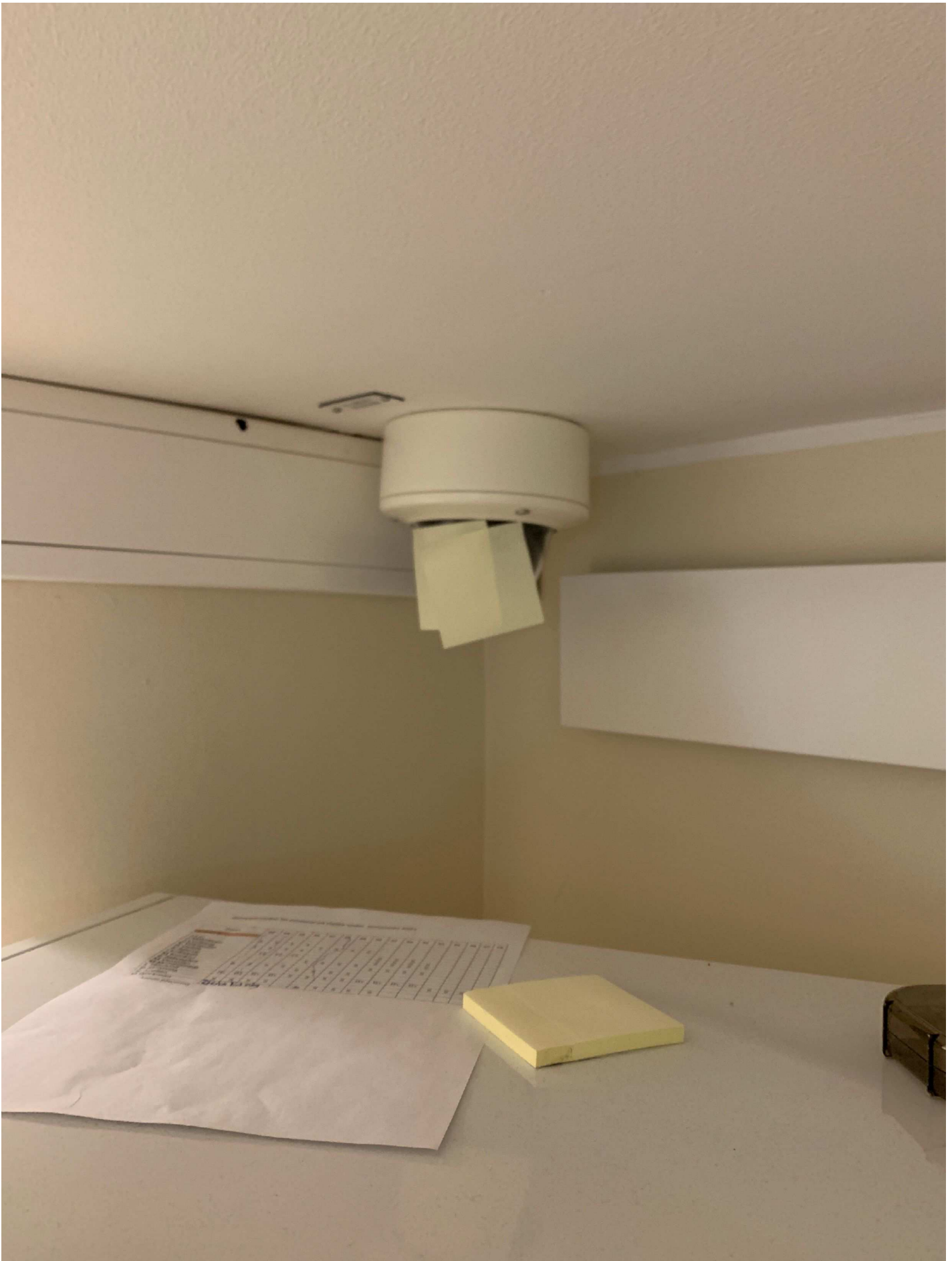
14. Bild som visar den övertäckta övervakningskameran inne i vaktrummet, ovanför kylan.
