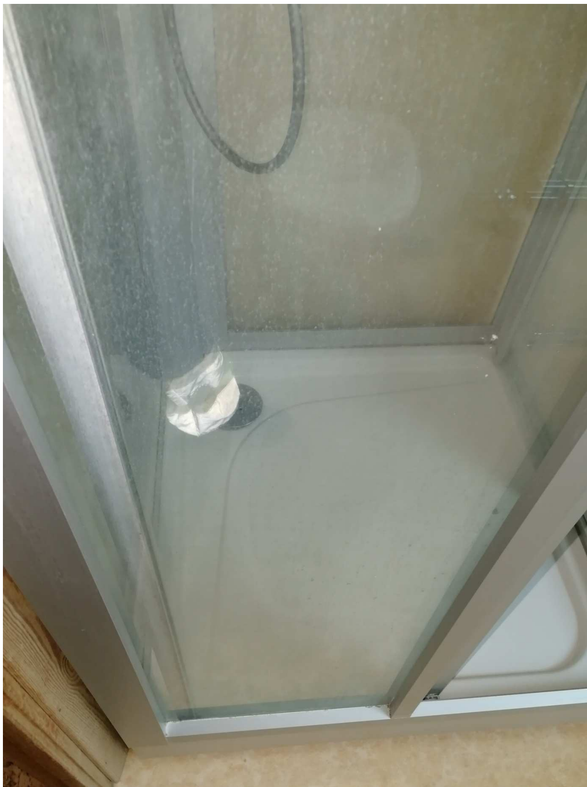
Duschkabinen på ovanvåningen
