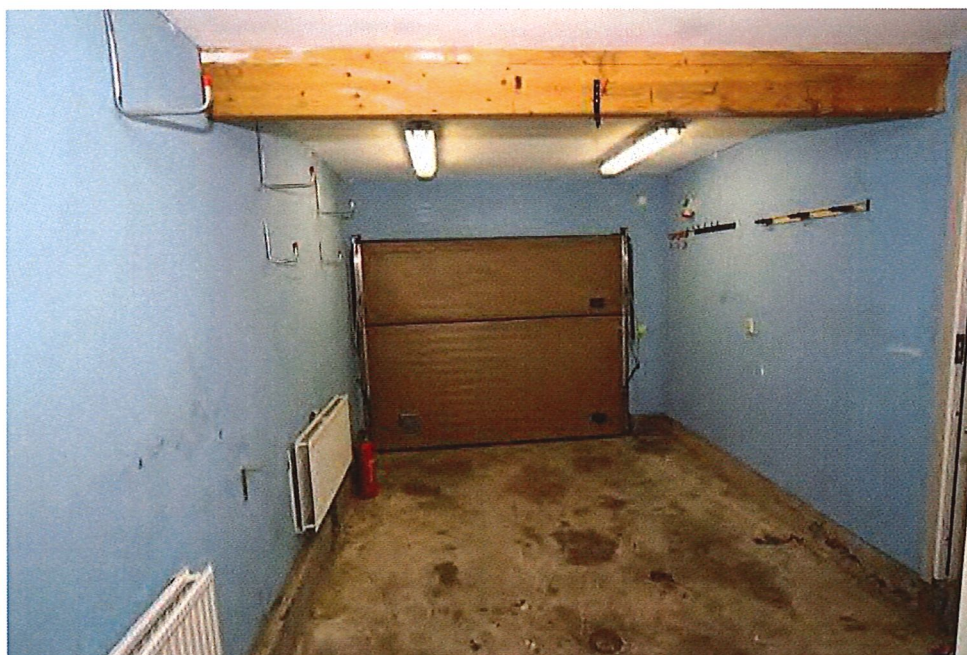
Figur 51. Garaget sett mot garageporten. Till höger utanför bild finns öppningen till förrådet.
