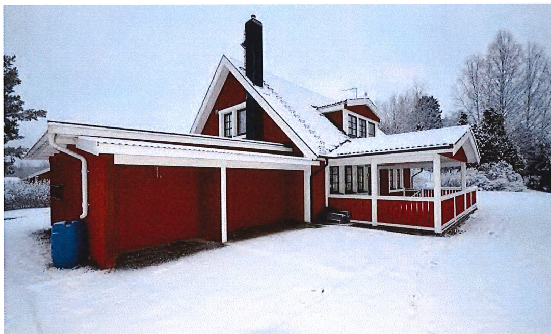
Figur 11. Baksidan av garaget.
