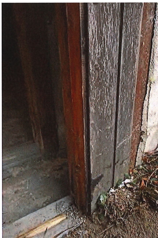
Figur 33. Bilden är tagen mot entrén till jordkällaren och visar den nedre delen av den högra dörrkarmen till den yttre dörren där likhunden markerade.
