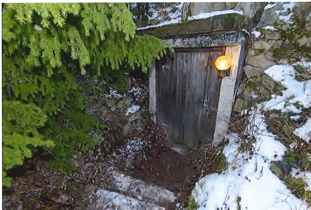
Figur 16. Entrén till jordkällaren.
