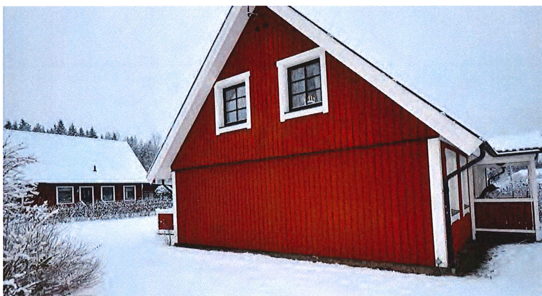
Figur 9. Fastighetens östra gavel.
