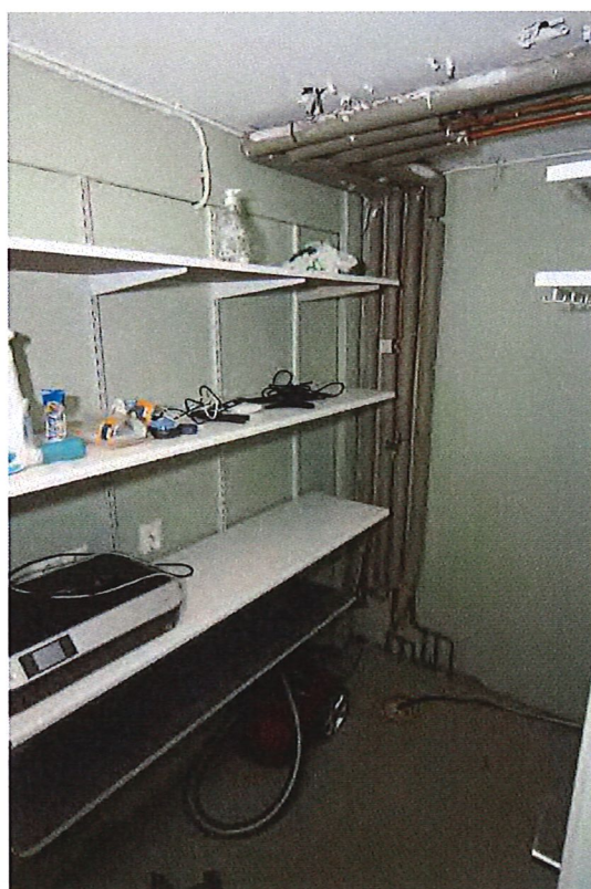
Figur 48. Bilden är tagen från garaget. Till vänster utanför bild finns öppningen till groventrén och till höger finns dörren till pannrummet.
