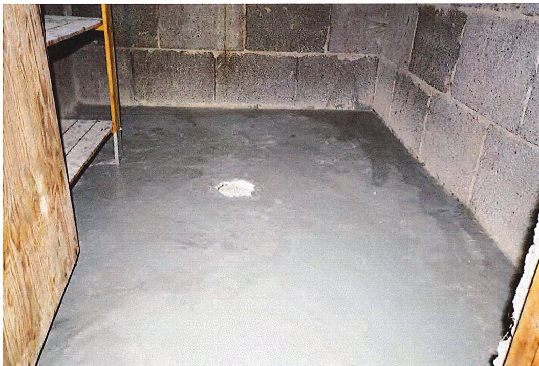
Figur 18. Golvutrymmet inne i jordkällaren.
