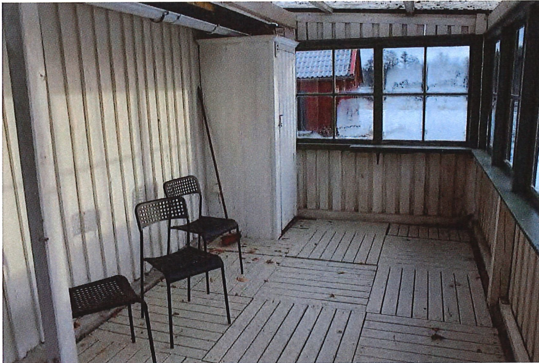
Figur 7. Glasveranda i anslutning till entrédörren.
