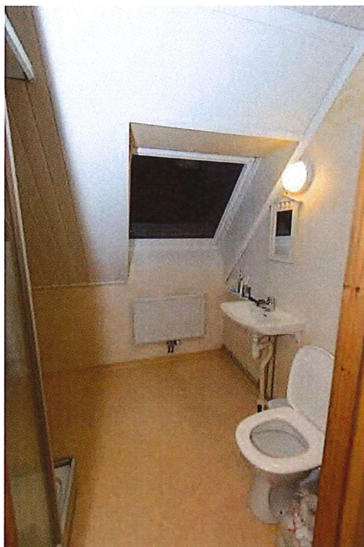
Figur 86. WC/duschrum sett från allrummet.
