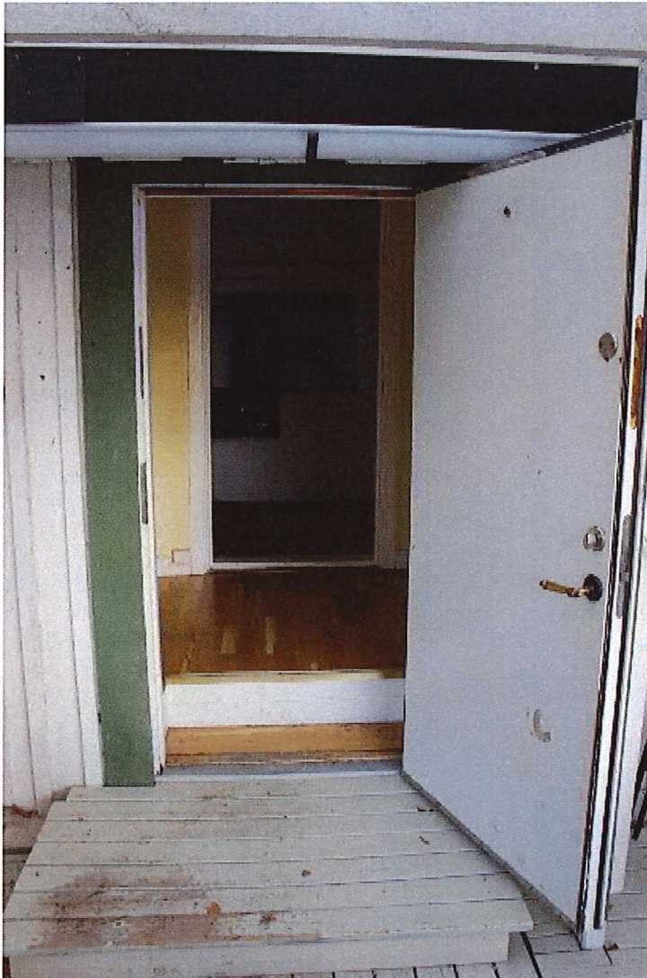
Figur 8. Sett från entrédörren, hallen och till höger låg badrum, rakt fram låg köket.
