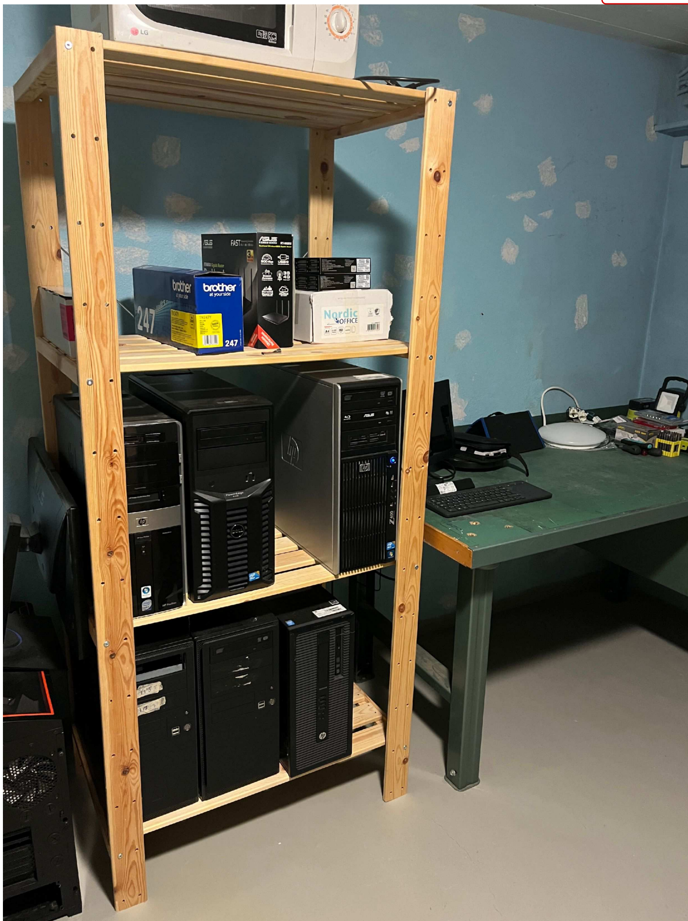
3. Hylla i JL teknikrum där den påslagna datorn var placerad. Mellanhyllan längst till höger
