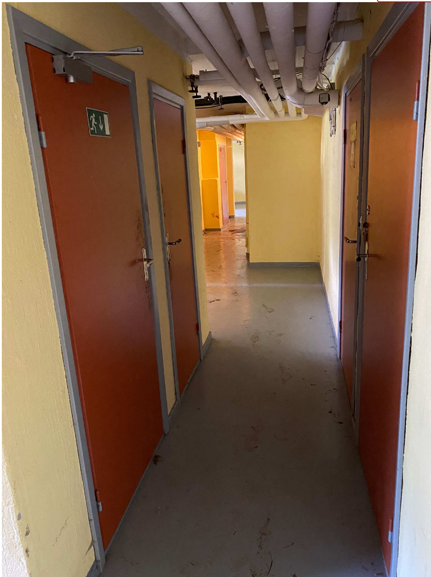
4. Till höger: Toalettdörr och trappuppgång. Till vänster: Dörr till pannrum och hobbyrum.
