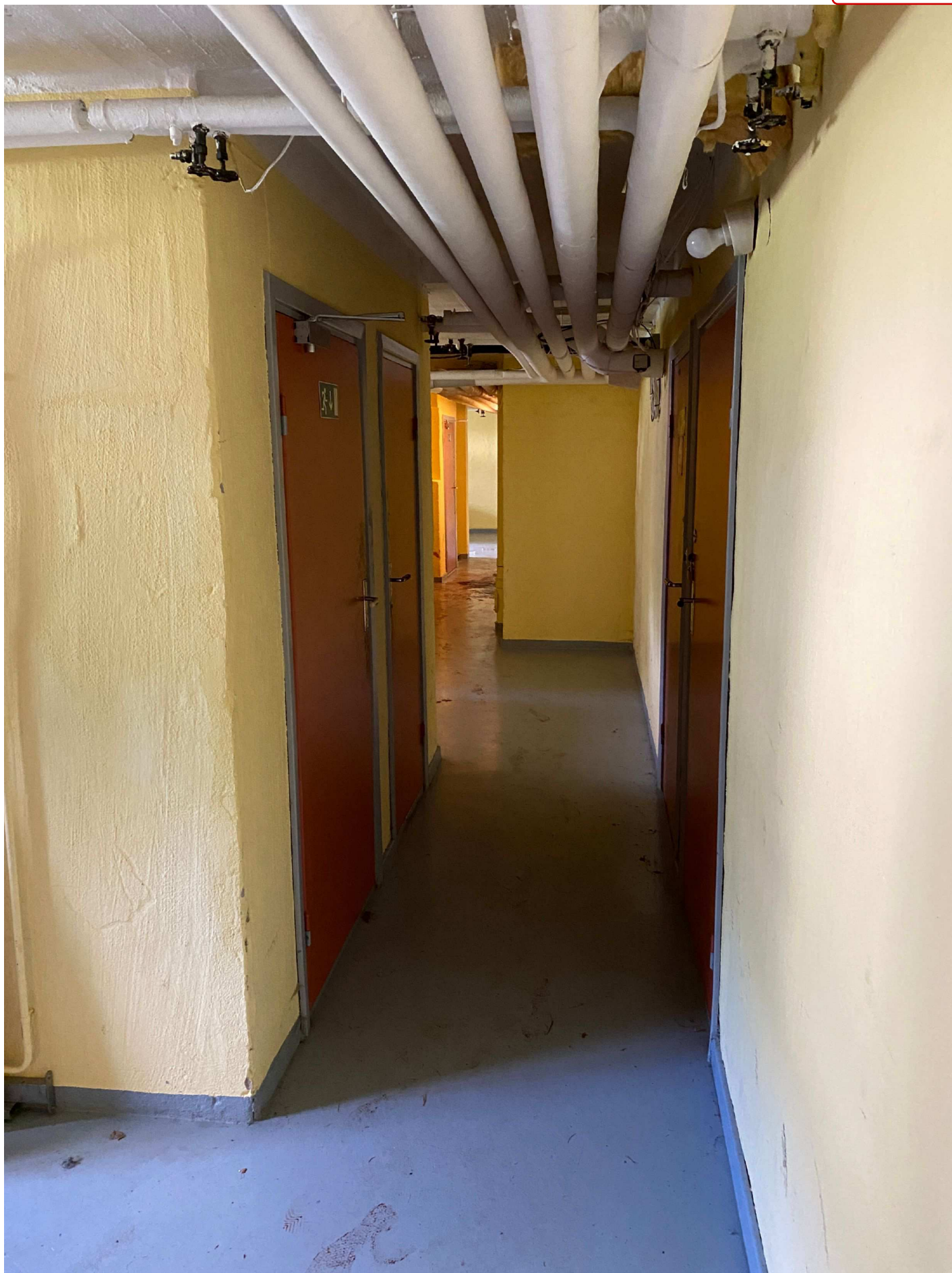
3. Till vänster: Trappuppgång och toalettdörr. Till vänster: Dörr till pannrum och hobbyrum.
