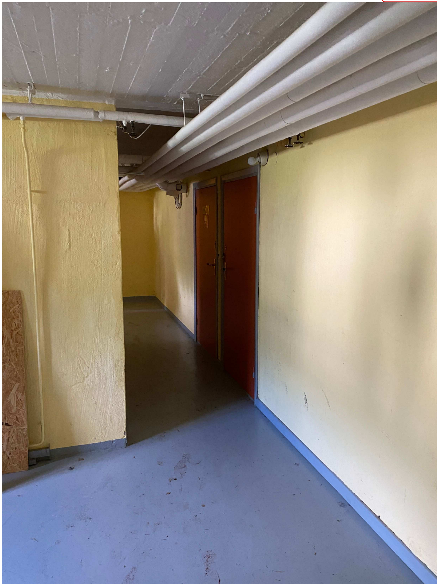
2. Till vänster: Trappuppgång och toalettdörr. Till vänster: Dörr till pannrum och hobbyrum.
