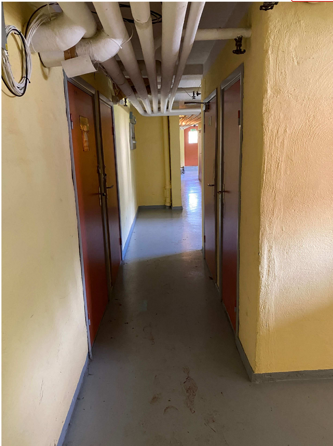
1. Till höger: Toalettdörr och trappuppgång. Till vänster: Dörr till pannrum och hobbyrum.
