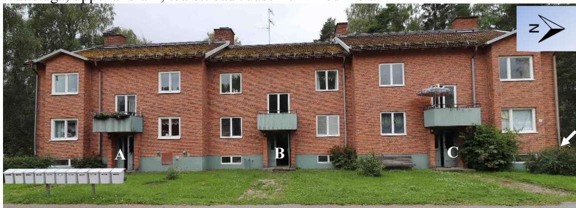
Figur 3. Översiktsbild Fäbodvägen 11, Horndal. Portar till trapphusen utmärkta med vita bokstäver A, B och C. Vit pil markerar riktning mot gaveln med dörren in till källarutrymmet.
