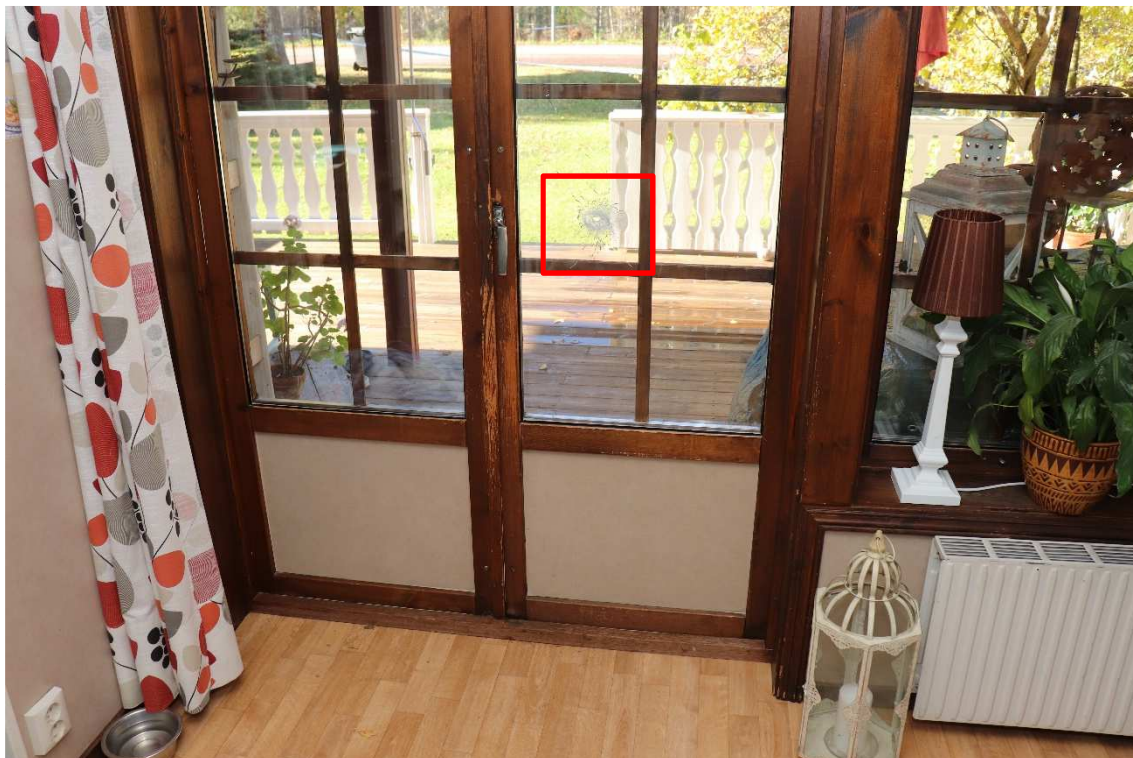
Figur 9. Bild tagen inifrån köket på Sandsäterbrovägen 61 mot altanen. Skotthålet markerat med röd ram.
