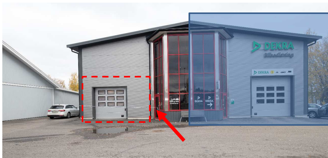
Figur 8. Västra gaveln på byggnaden.
